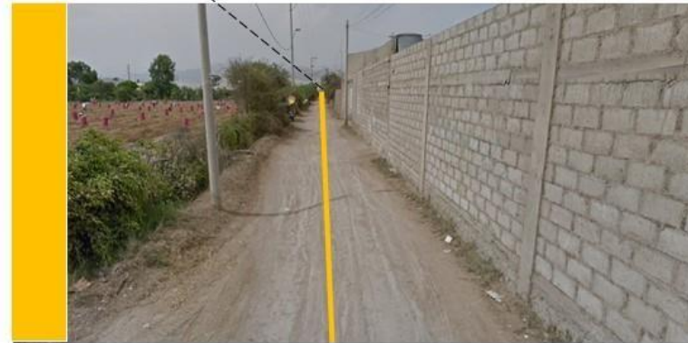
VIAS COLECTORAS, AVENIDA 3, CALLE 2, 3 Y 4
