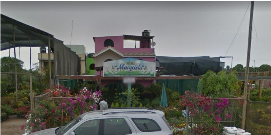
Figura 66: Viviendas y comercio Fuente: Elaboración propia
