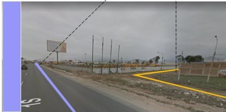
CARRETERA PANAMERICANA SUR
