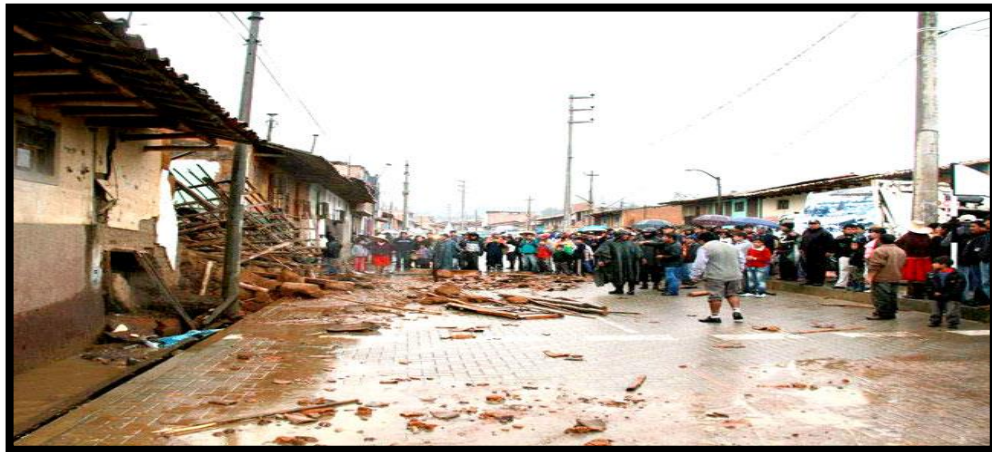
Gráfico 16. Viviendas mal construidas colapsan a causa de lluvias
