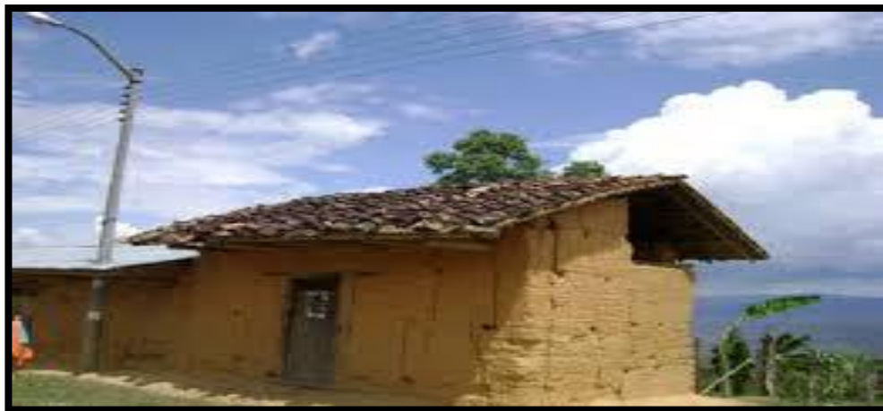
Gráfico 18. Autoconstrucción de vivienda de adobe
