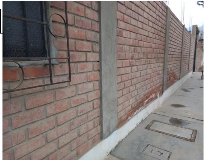
En la imagen se observa Humedad en el sobrecimiento y muros con presencia de eflorescencias.
