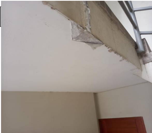
En la imagen se observa descascaramiento de la pintura en losa aligerada producto de la humedad.
