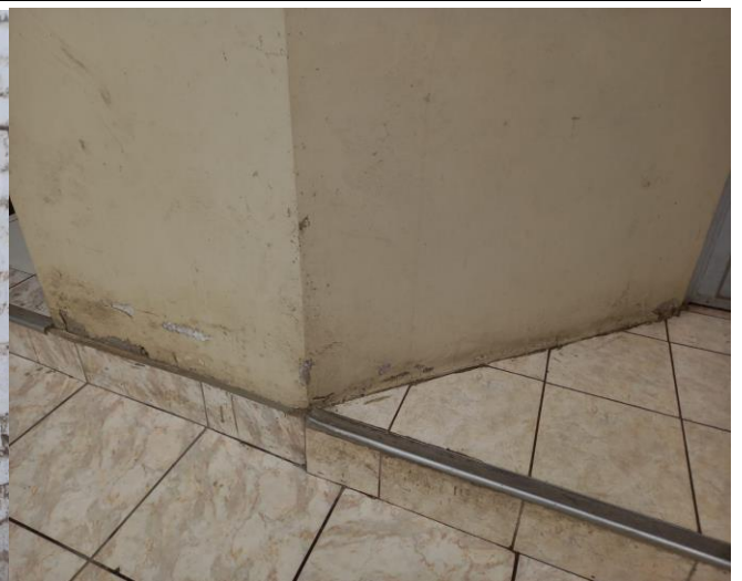
En la imagen se observa Humedad en el sobrecimiento y muros con presencia de eflorescencias.
