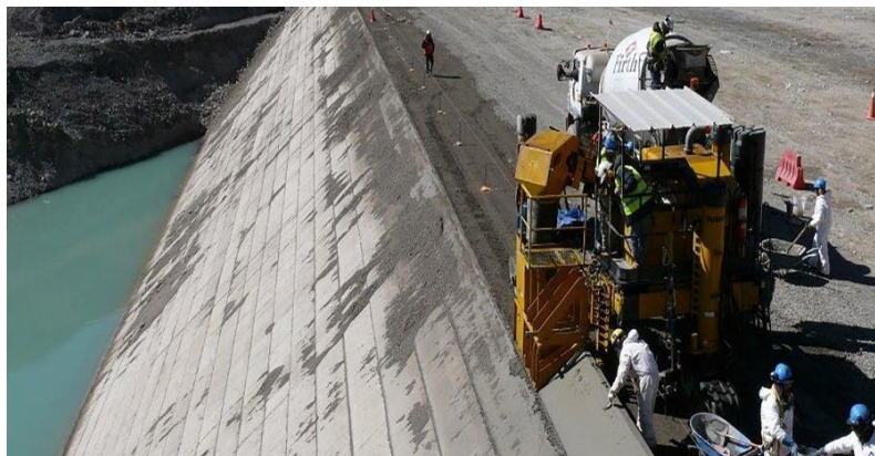
Figura 1 Colocación del concreto bordillo
