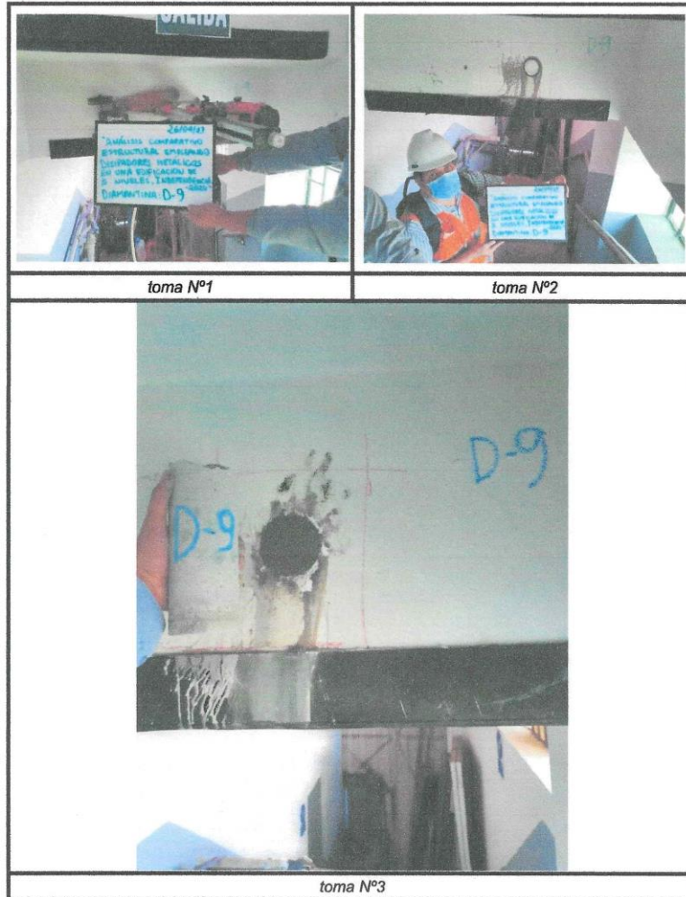
Figura N° 21: Área de la zona de trabajo e instalación de equipos de trabajo. Elaboración: Fuente Propia
