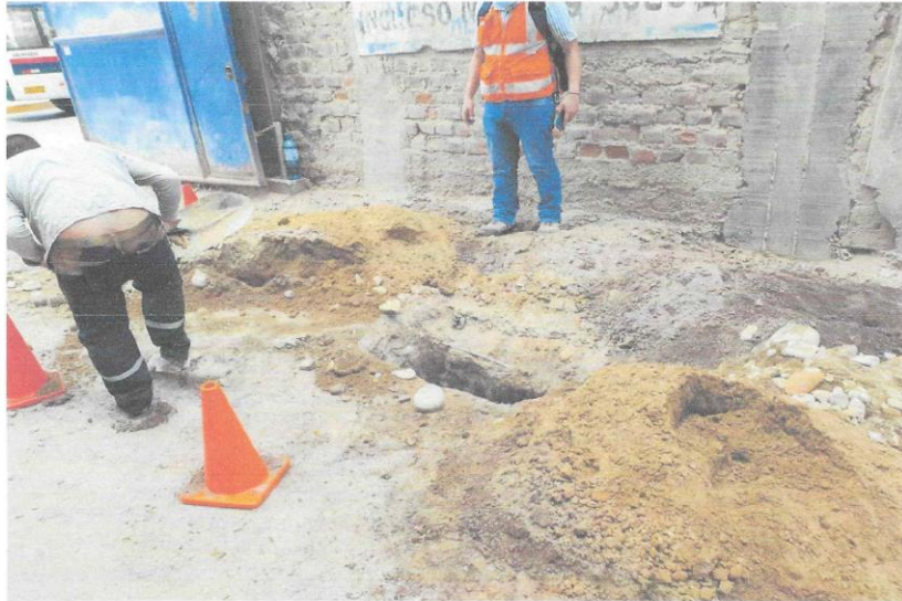
Foto N°1 - Vista panoramica de la calicata C-1
