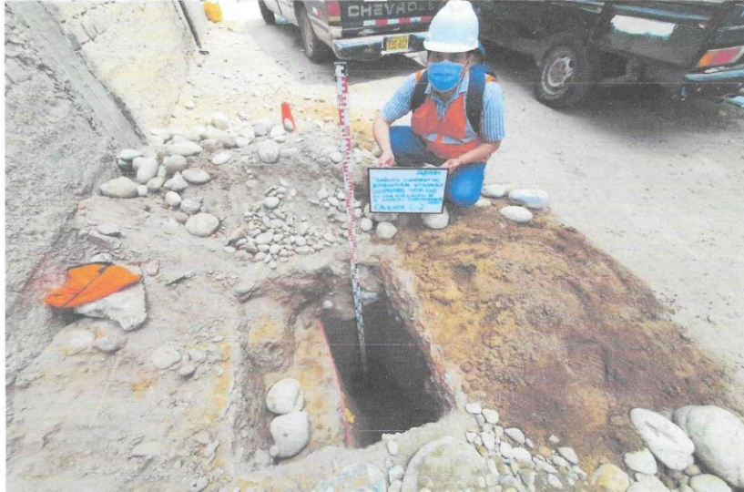
Foto N°3 - Vista panorámica de la calicata C-2
