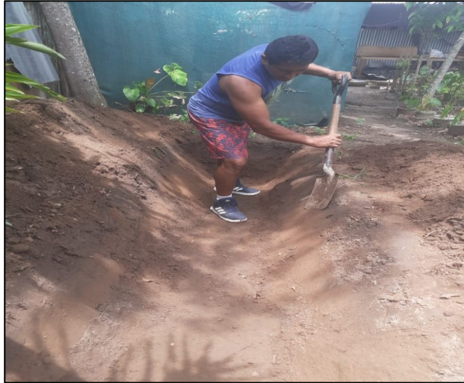
Figura N° 07: Excavación de la zanja.
