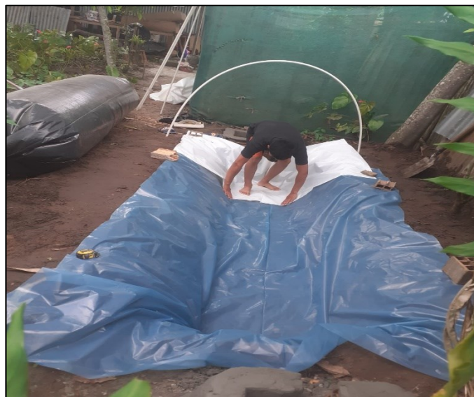
Figura N° 09: Recubrimiento de la zanja del biodigestor.
