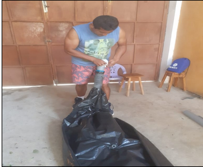
Figura N° 05: Formación de la bolsa anaeróbica.
