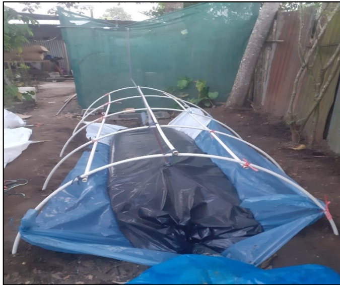
Figura N° 10: Construcción de techo invernadero del biodigestor.
