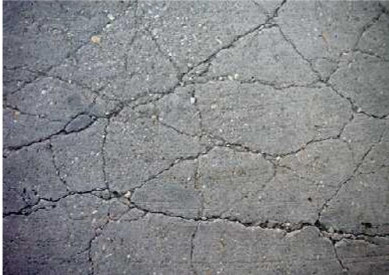
**Figura 14:** Contracciones en el concreto
