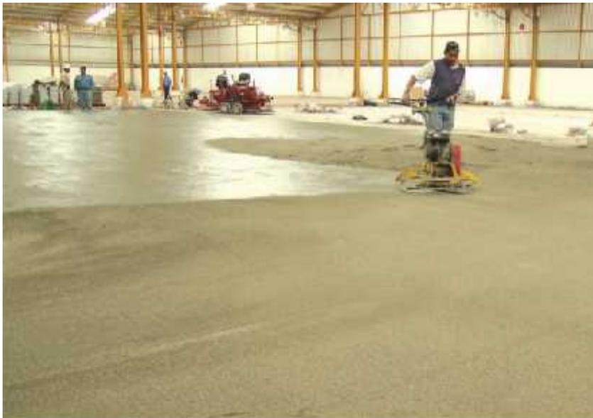
**Figura 15:** Construcción de pisos industriales
