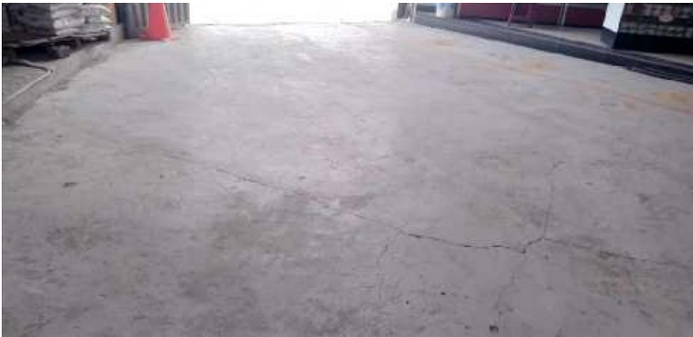
**Figura 16:** Agrietamientos de pavimento a causa de cargas.
