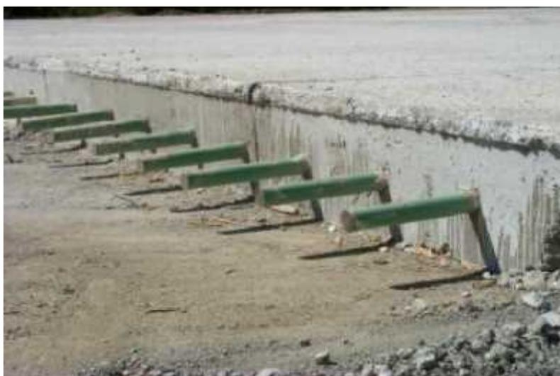
**Figura 20:** Pasadores en una junta de construcción de un pavimento rígido
