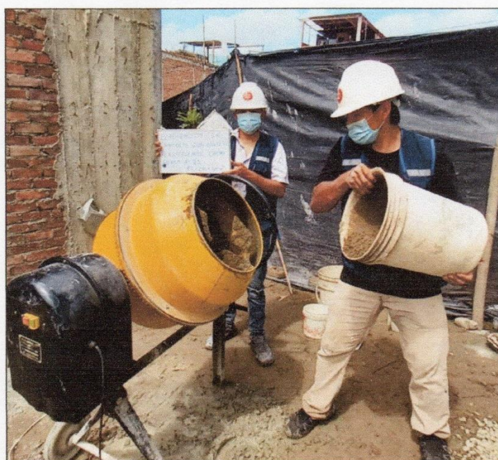
FOTOGRAFÍA 30: Adición de agregado fino a la mezcladora de concreto.
