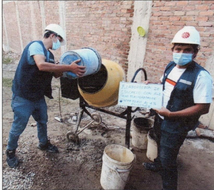
FOTOGRAFÍA 12: Adición de agregados a la mezcladora de concreto.
