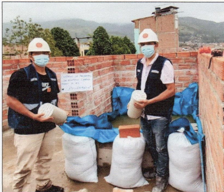
FOTOGRAFÍA 17: Colocación de probetas a la piscina de curado.
