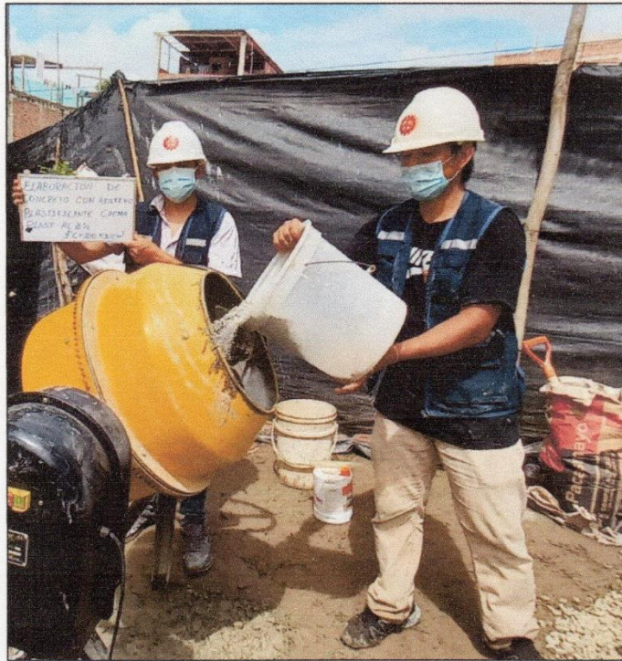
FOTOGRAFÍA 31: Adición de cemento Extra Forte (Pacasmayo).
