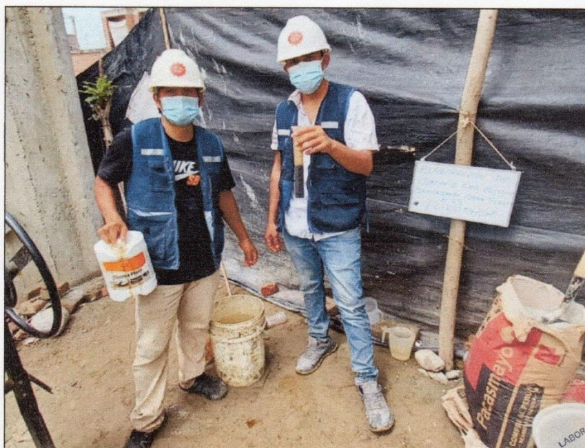
FOTOGRAFÍA 20: Medición de aditivo Chema Plast al 6%.
