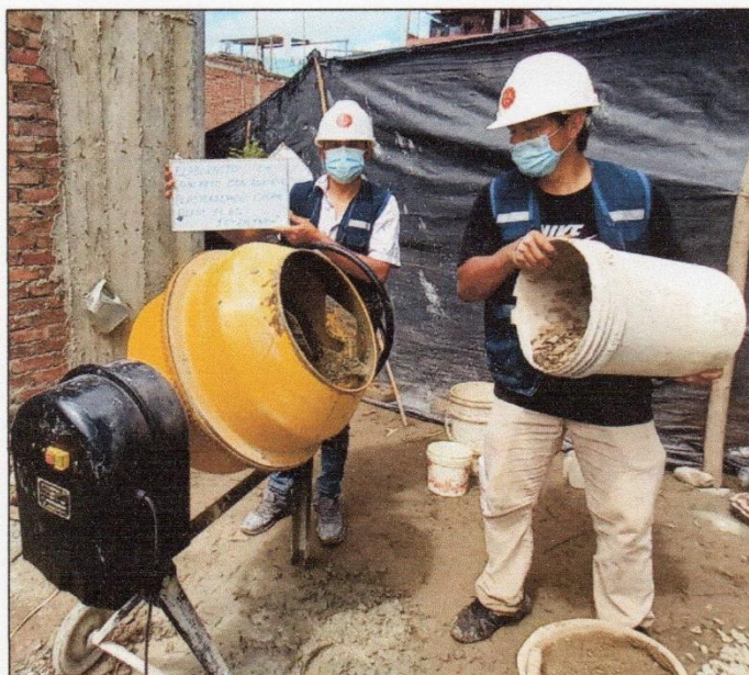
FOTOGRAFÍA 29: Adición de agregados grueso a la mezcladora de concreto.
