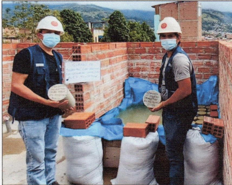
FOTOGRAFÍA 35: Colocación de probetas a la piscina de curado.
