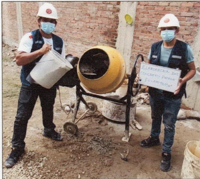
FOTOGRAFÍA 03: Adición de cemento a la mezcla de concreto Patrón.
