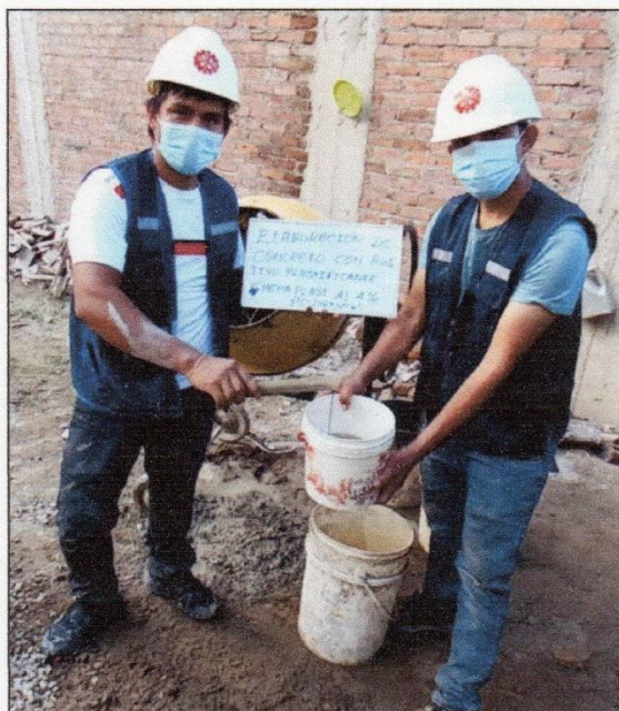
FOTOGRAFÍA 11: Adición de aditivo Chema Plast a la proporción de agua para la mezcla de concreto.
