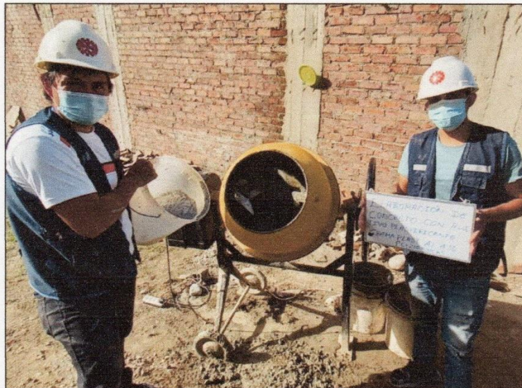
FOTOGRAFÍA 13: Adicción de cemento a la mezcladora de concreto.
