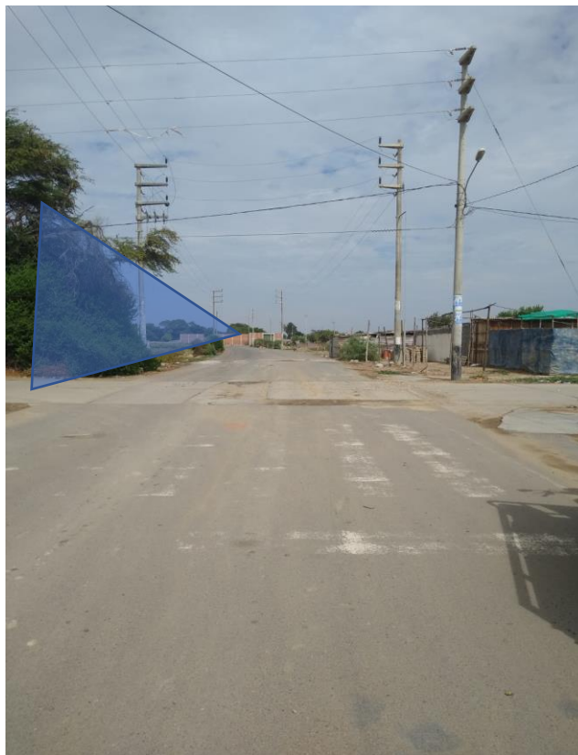
Figura n° 13 vista de la carretera annape
