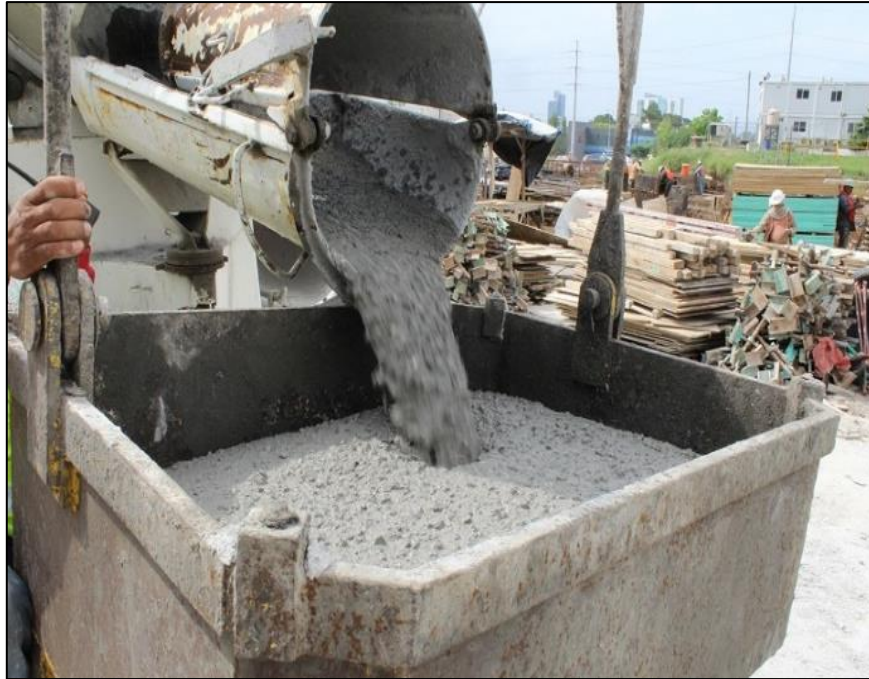
Figura 08. Mezcla de agregado, cemento y agua.
