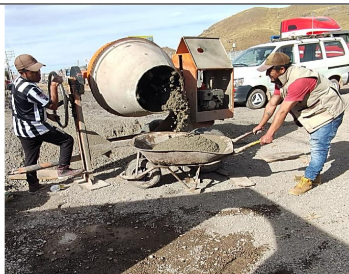
Mezclador de concreto con trompo..
