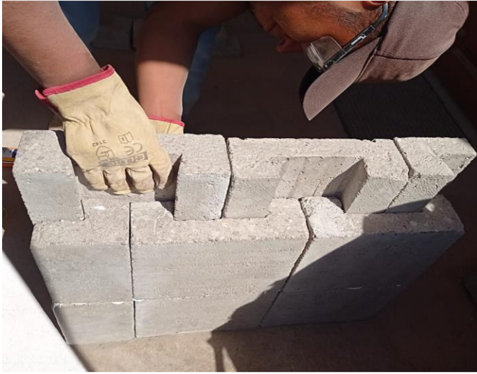
Proceso, armado de murete con bloque tipo I.
