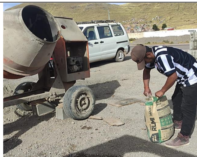
Inicio de procedimiento con el trompo mezclador de concreto.
