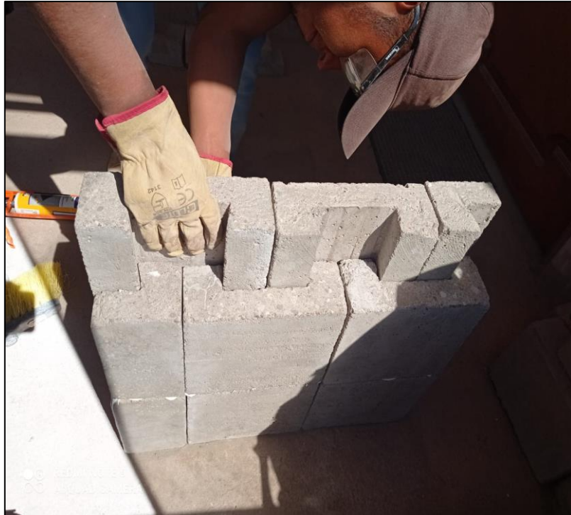
Figura 54. Elaboración de Murete con bloques tipo I.
