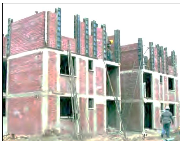
Figura 01. Función estructural de albañilería.
