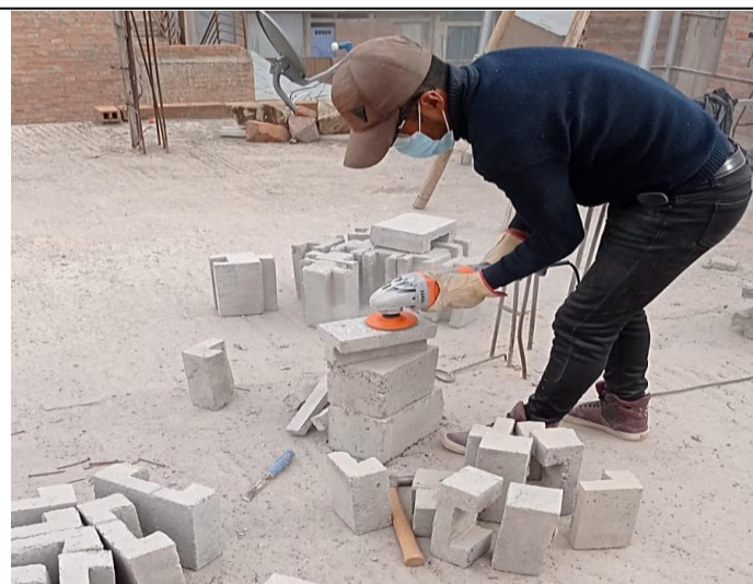
Perfilado y corte del bloque tipo I.
