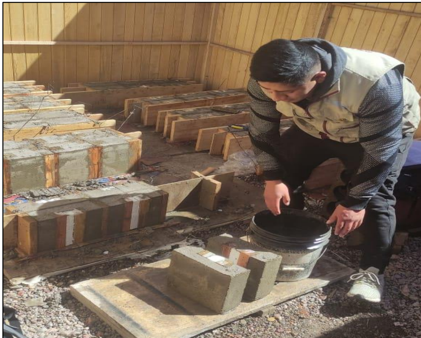
Figura 39. Desmolde de los bloques tipo I y II.
