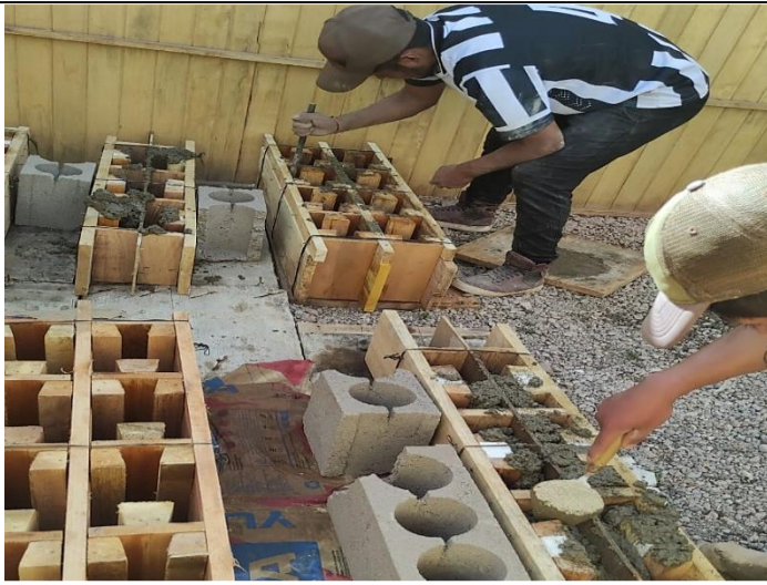
Vaciado de concreto en los moldes de los bloques.
