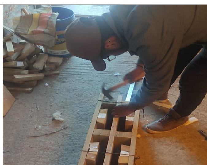
Proceso de armado del molde tipo I.
