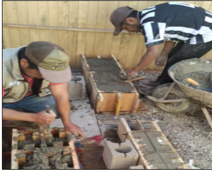
Figura 38. Varillado del concreto para eliminar los espacios vacíos.
