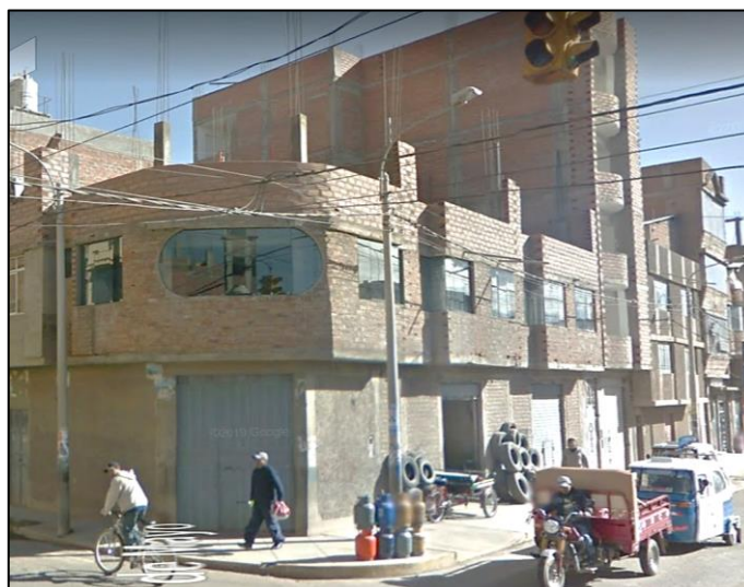
Figura 02. Edificaciones de albañilería - (Juliaca 2021).
