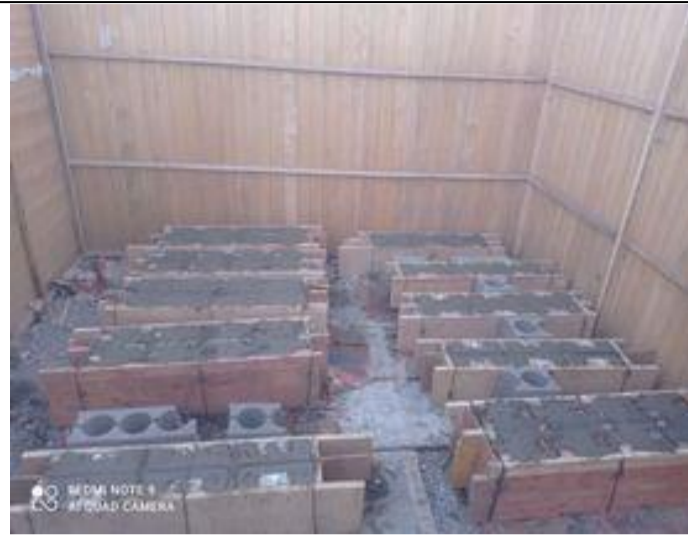
Finalización del vaciado de los diferentes moldes y nivelado.
