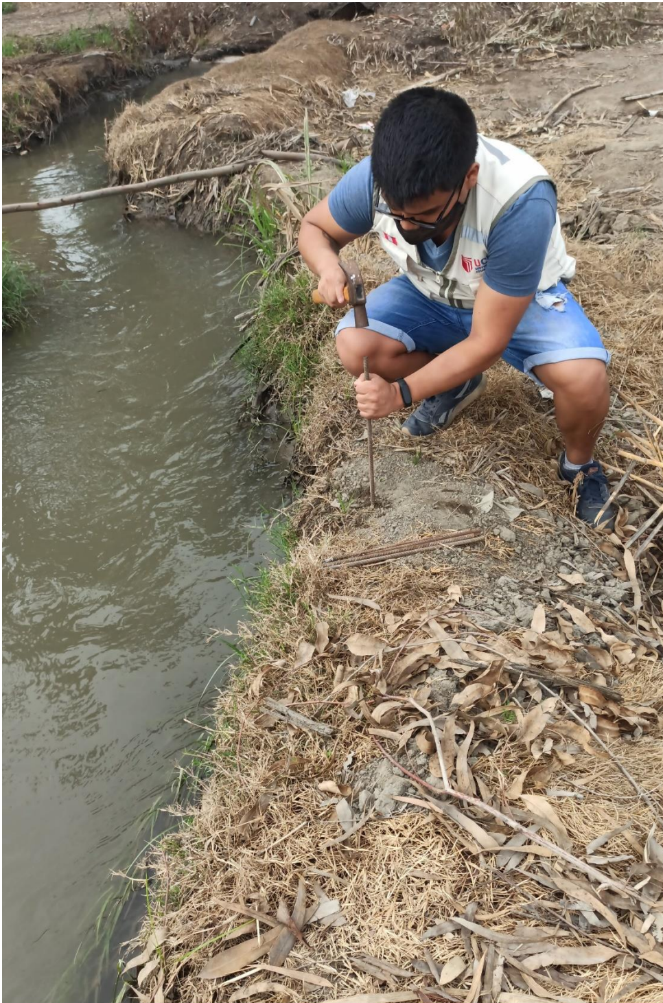
Figura 25 – Clavado de estacas
