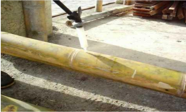
Imagen 8: Se aprecia la inyección en la pieza de bambú
