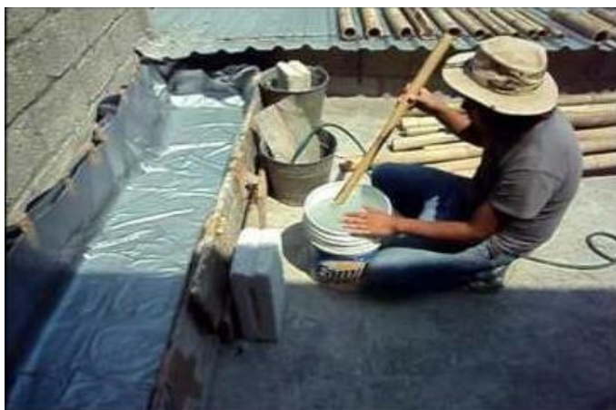
Imagen 6: Curado de piezas de bambú por inmersión de agua.
