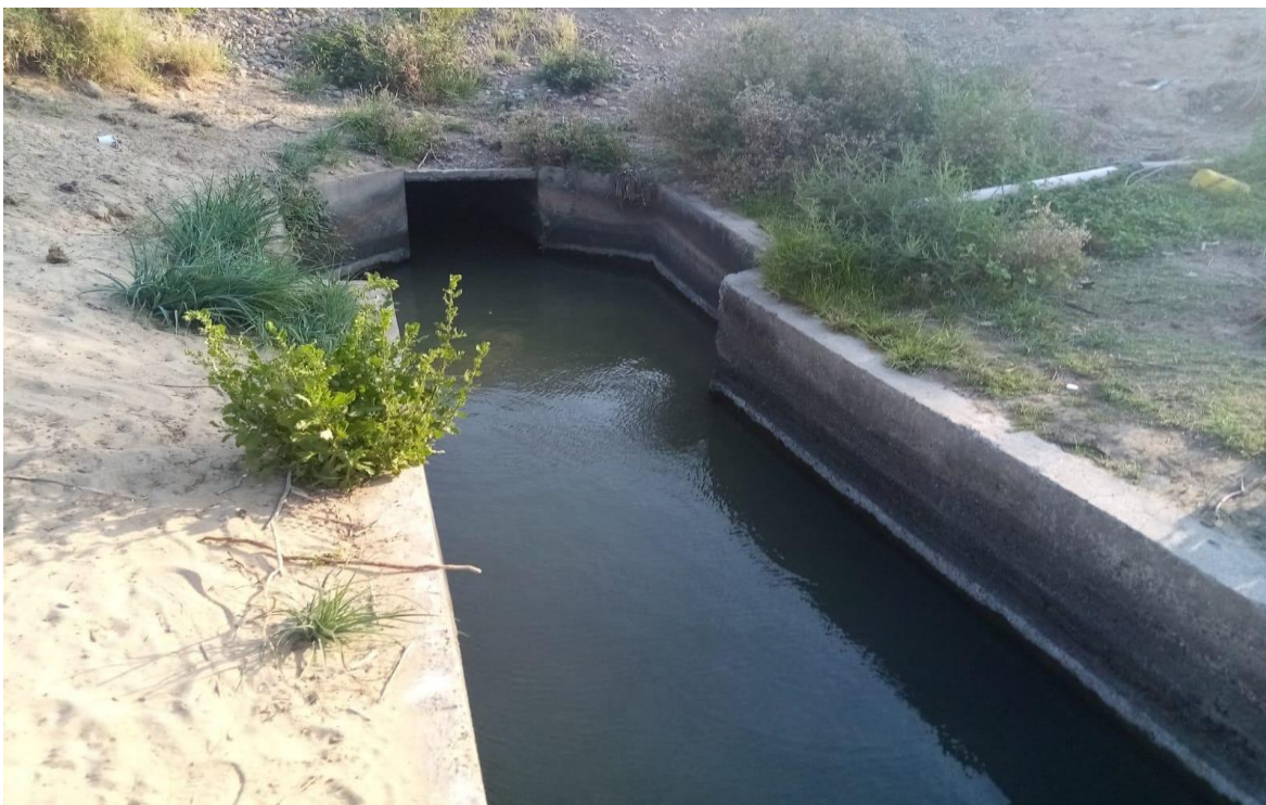
FIGURA N°04: OBRA DE ARTE EXISTENTE, ALIVIADERO Y ACUEDUCTO
