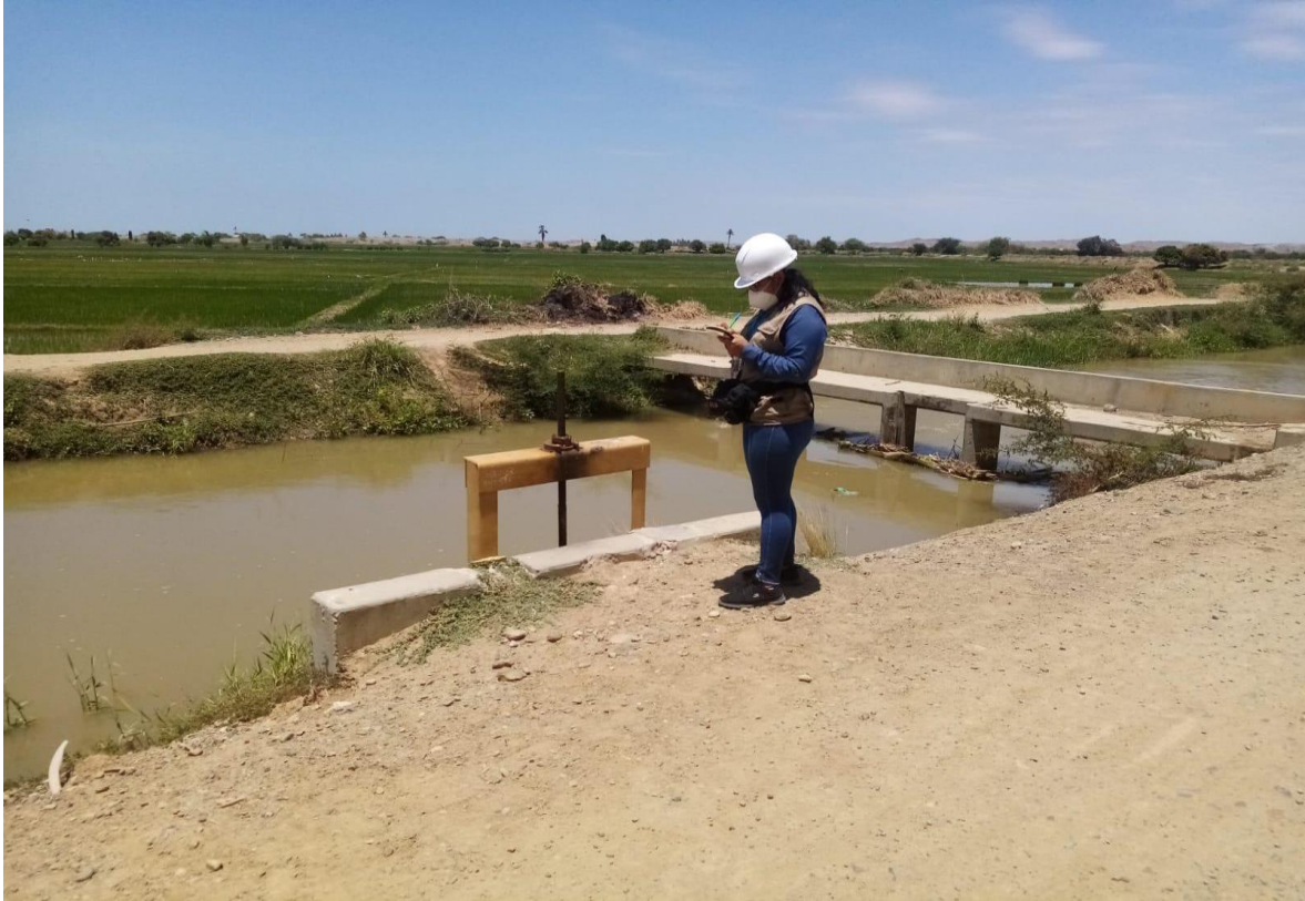
FIGURA N.º01: TOMA LATERAL COMPUERTA SAN JOSE, PROGRESIVA 054+813 KM. CANAL MIGUEL CHECA
