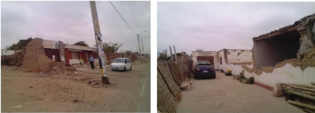
Figura N°3. Vista de las inadecuadas condiciones físicas de accesibilidad a la planta.
