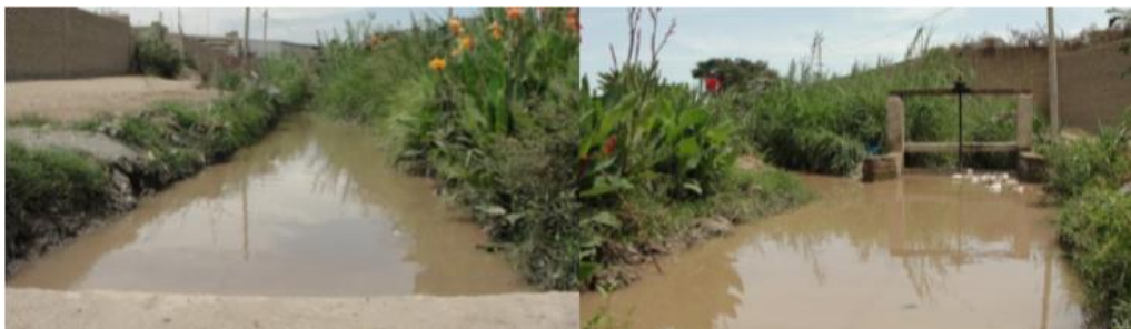
Figura N°28. Vista de los caudales de las acequias del distrito de Sunampe
