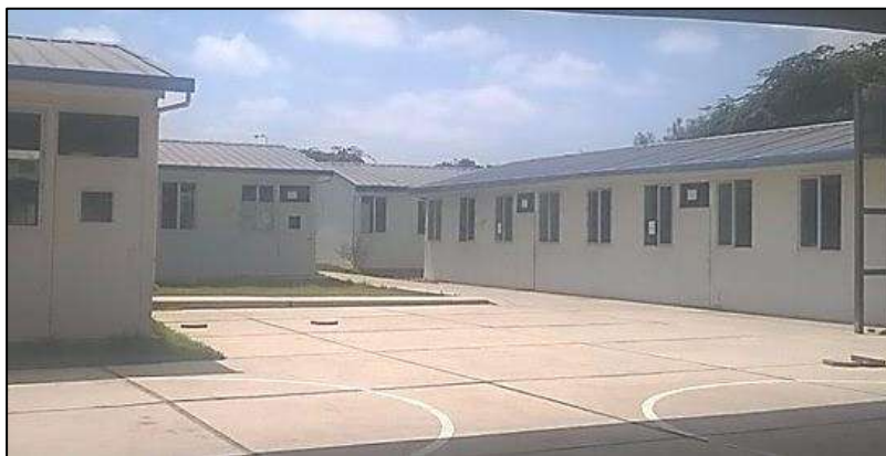
Figura 4: Vista de interiores del área residencial. Fuente: Elaboración propia.
