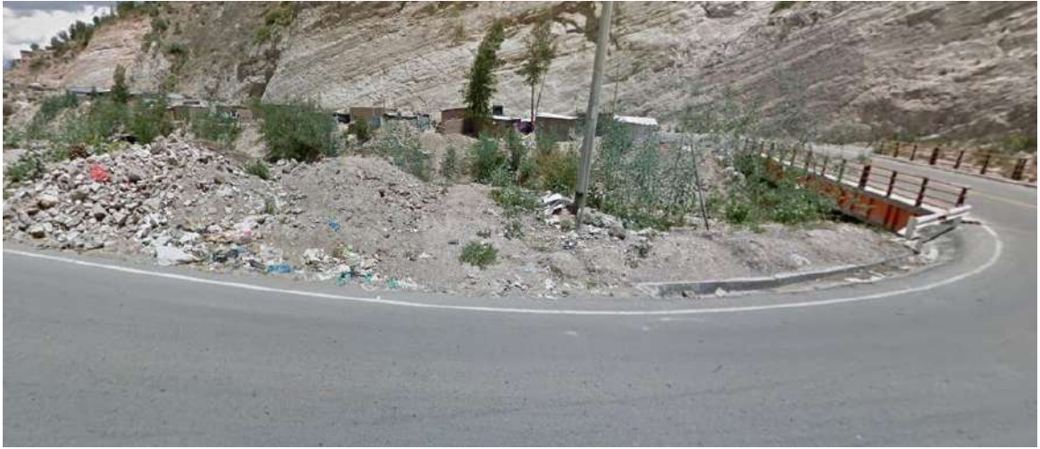
Figura 13: Vista de la vía hacia Mollepata. Fuente: Elaboración propia.
