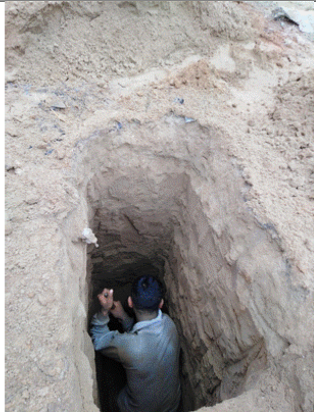
Excavación de la calicata 03
