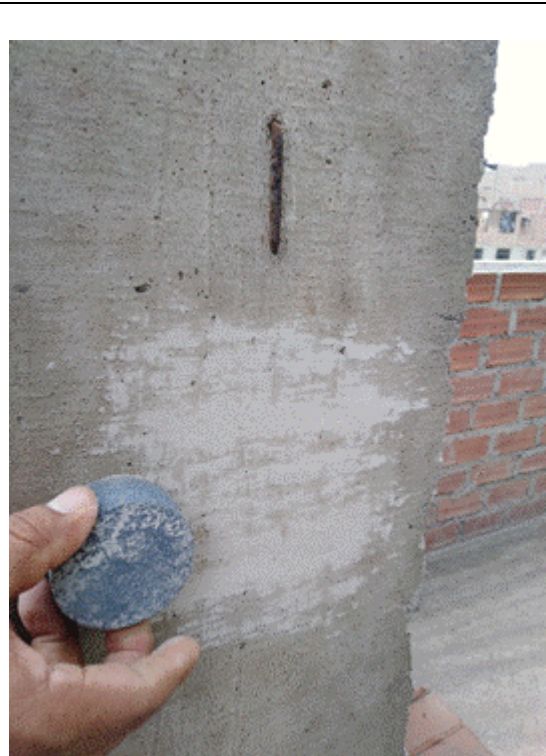
Limpieza de zona de trabajo con piedra abrasiva
