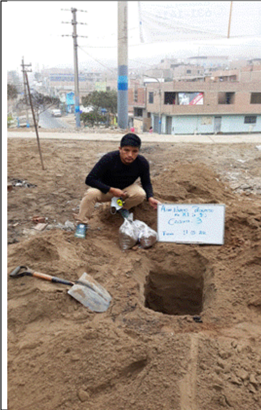
Verificación de altura C-03
