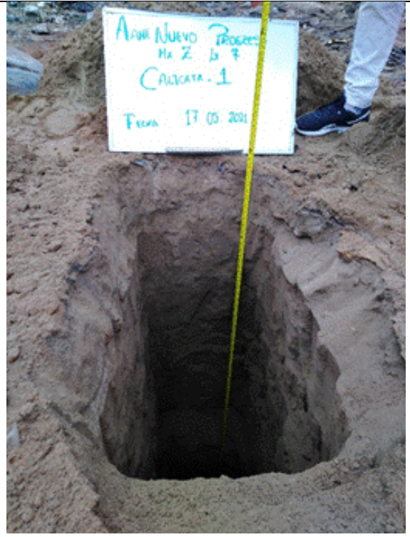
Verificación de altura calicata N°01
