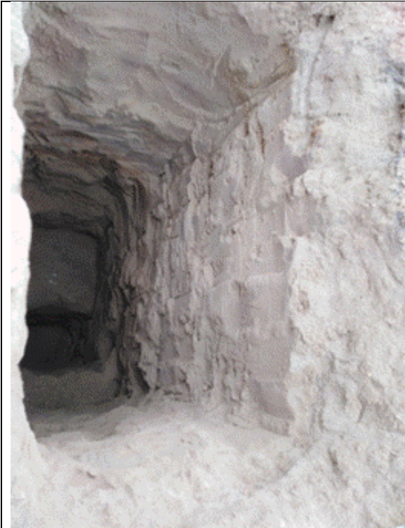
Excavación de calicata N°01
