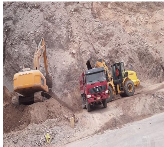
Figura 17. Eliminación de over.
