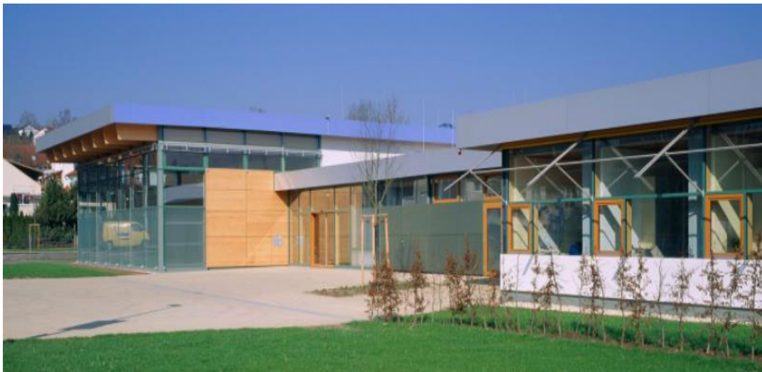
Figura 29: Vista de del ingreso principal.
