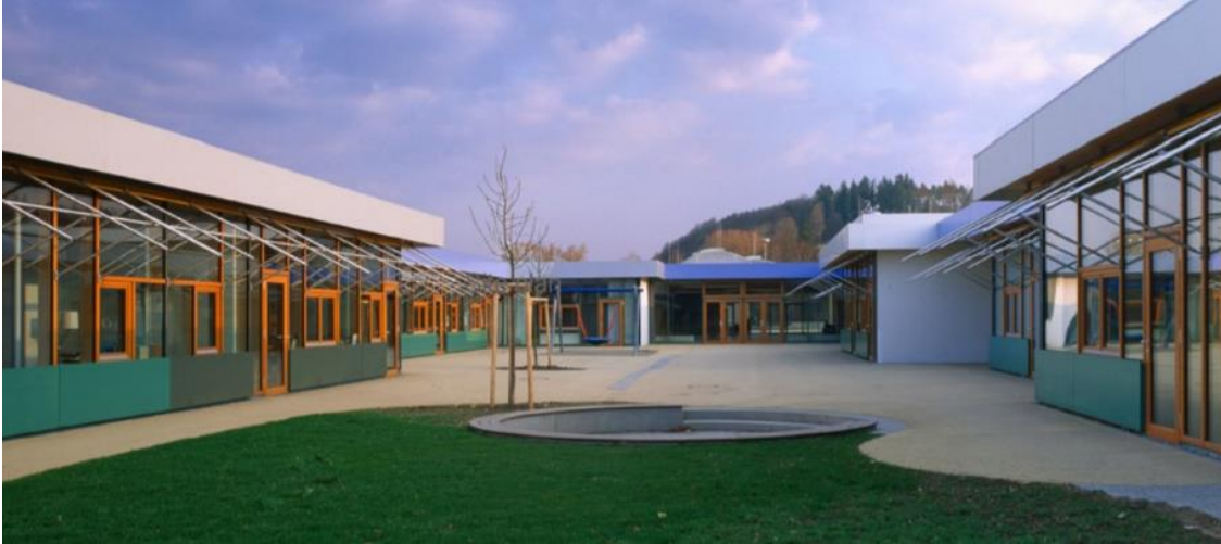
Figura 30: Vista de fachada interior del patio.
