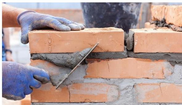
Figura N°7: Aplicación del Mortero
