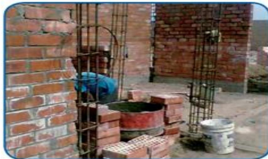
Figura N°1: Albañilería Confinada
