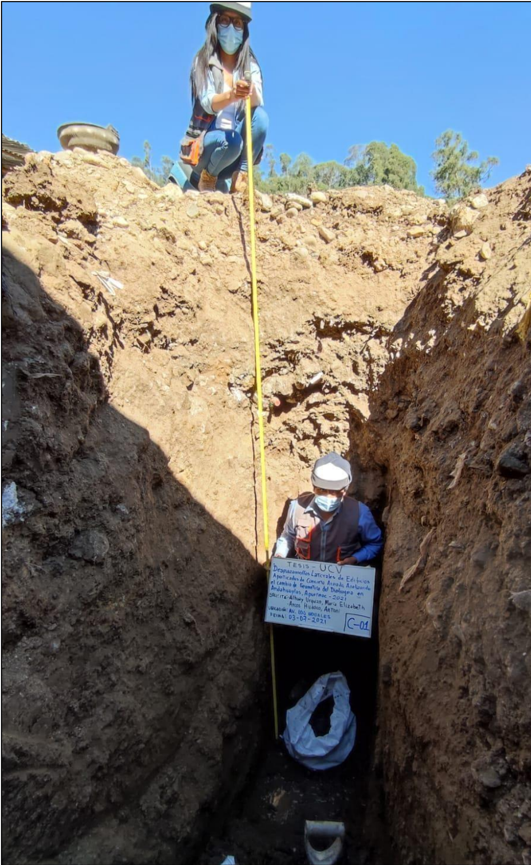
Figura 3: Perfil estratigráfico con presencia de nivel freático, calicata (C-01).
