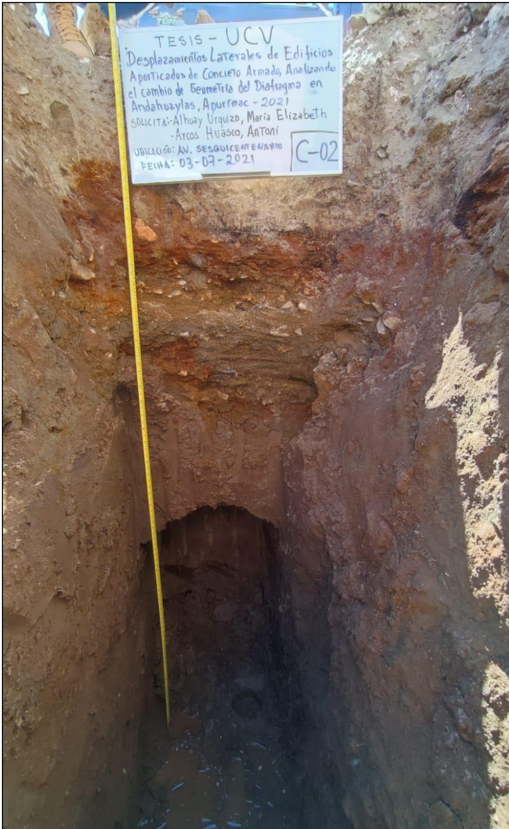
Figura 4: Perfil estratigráfico con presencia de nivel freático, calicata (C-02).
