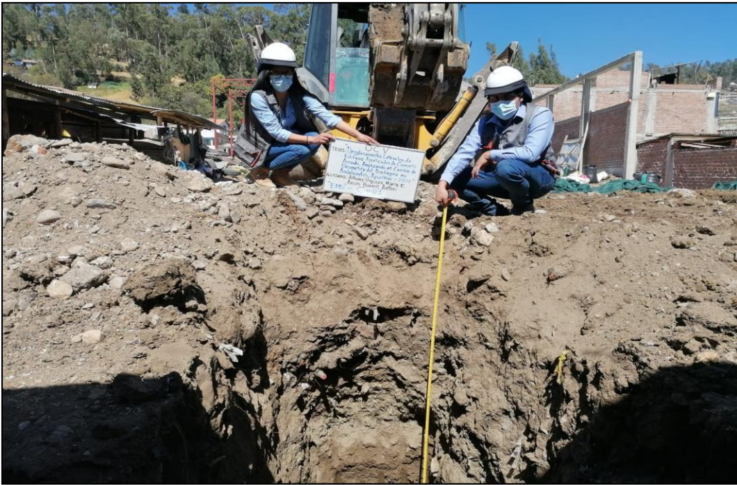
Figura 1: Extracción de material de la calicata (C-01), Av. Los Nogales.
