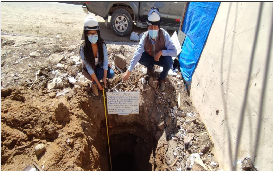
Figura 2: Extracción de material de la calicata (C-02), Av. Sesquicentenario.
