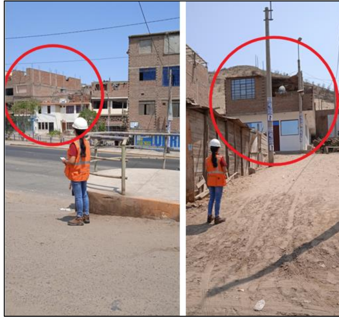
Figura 4. Viviendas inconclusas en la zona de estudio Fuente: Elaboración Propia
