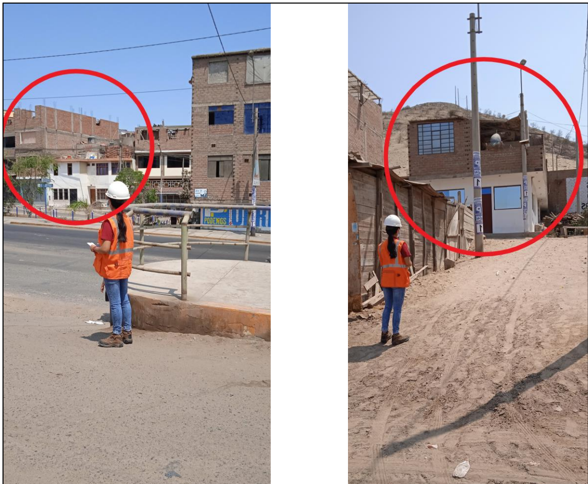
Imagen: Viviendas inconclusas de 2 a 4 pisos Fuente: Elaboración Propia
