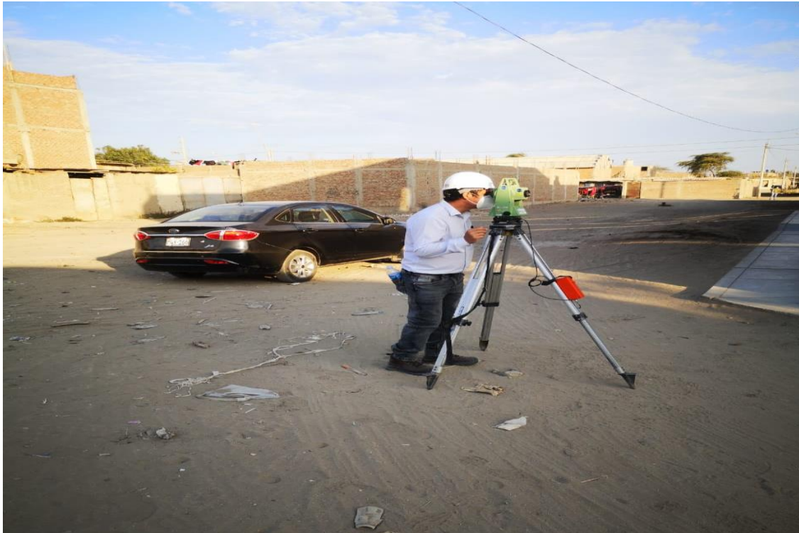
Figura: Integrante de brigada utilizando la estación total en campo.
