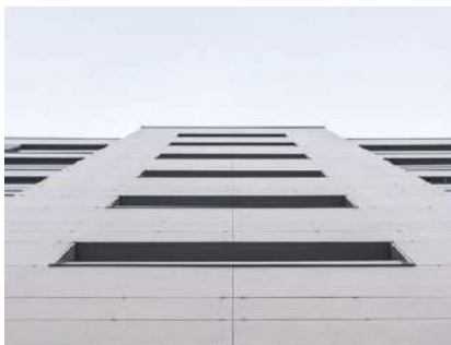
Figura 159: Fachada de porcelánico
