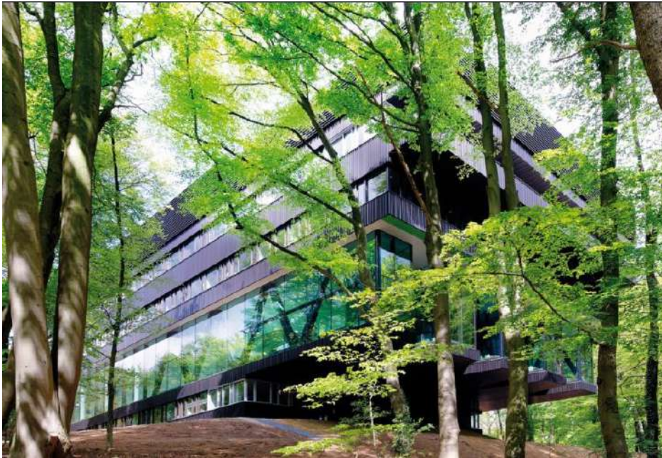
Figura 123: Centro de Rehabilitación Groot klimmendaal
