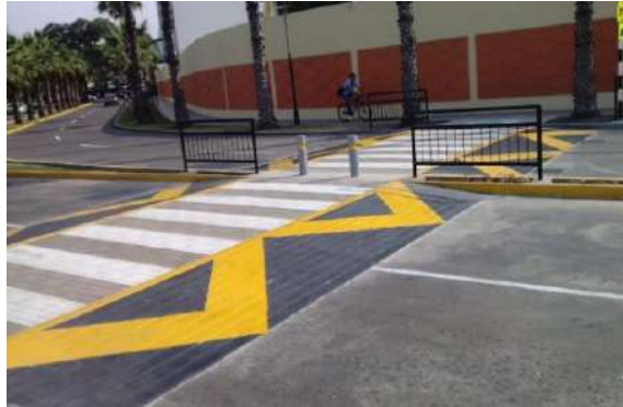
Figura 179: Implementación de camellones
