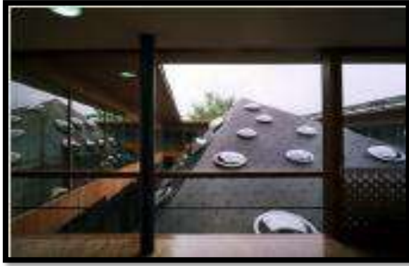
Figura 104 : Techo de piscina terapéutica exterior
