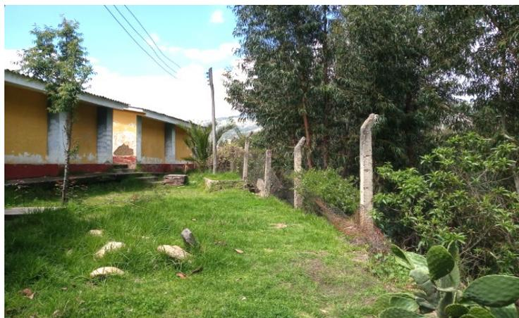
*Figura 3.* Cerco perimétrico conformado por columnas de concreto y malla metálica en mal estado.
