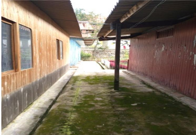
*Figura 2.* Presencia de humedad y moho en pasaje de circulación de la edificación.
