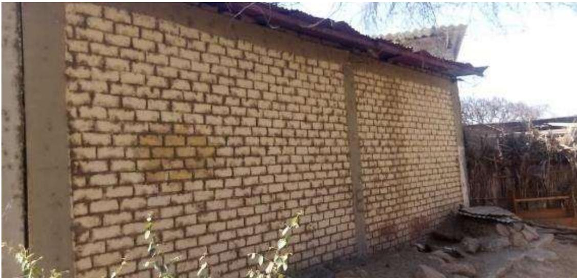
Foto N° 08. Las aulas cuentan con techo de calamina, la misma que se encuentra deteriorada y carecen de veredas perimetrales.
