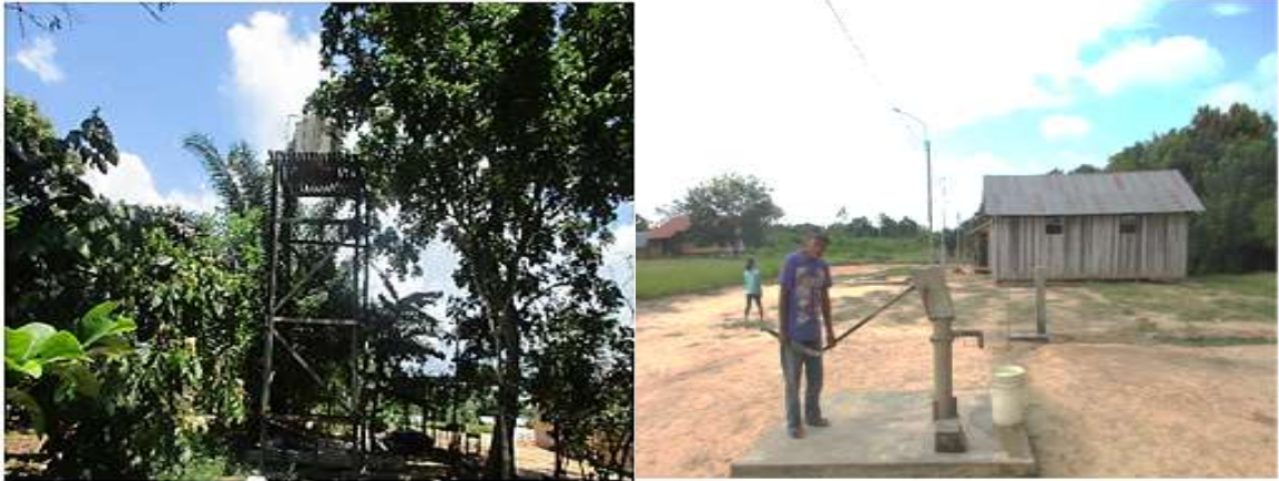
Figura 15: Vista de pozo artesiano existente inoperativo pozo tubular referencia familia Noriega lomas. Y vista de pozo tubular con bomba manual N° 02 existente inoperativo.
