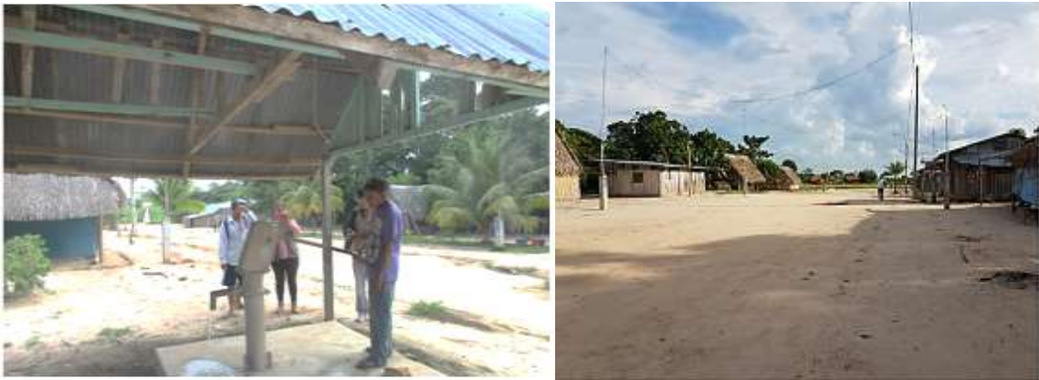
Figura 16: Vista de pozo tubular con bomba manual N° 1 existente y operativo y sistema eléctrico en viviendas
