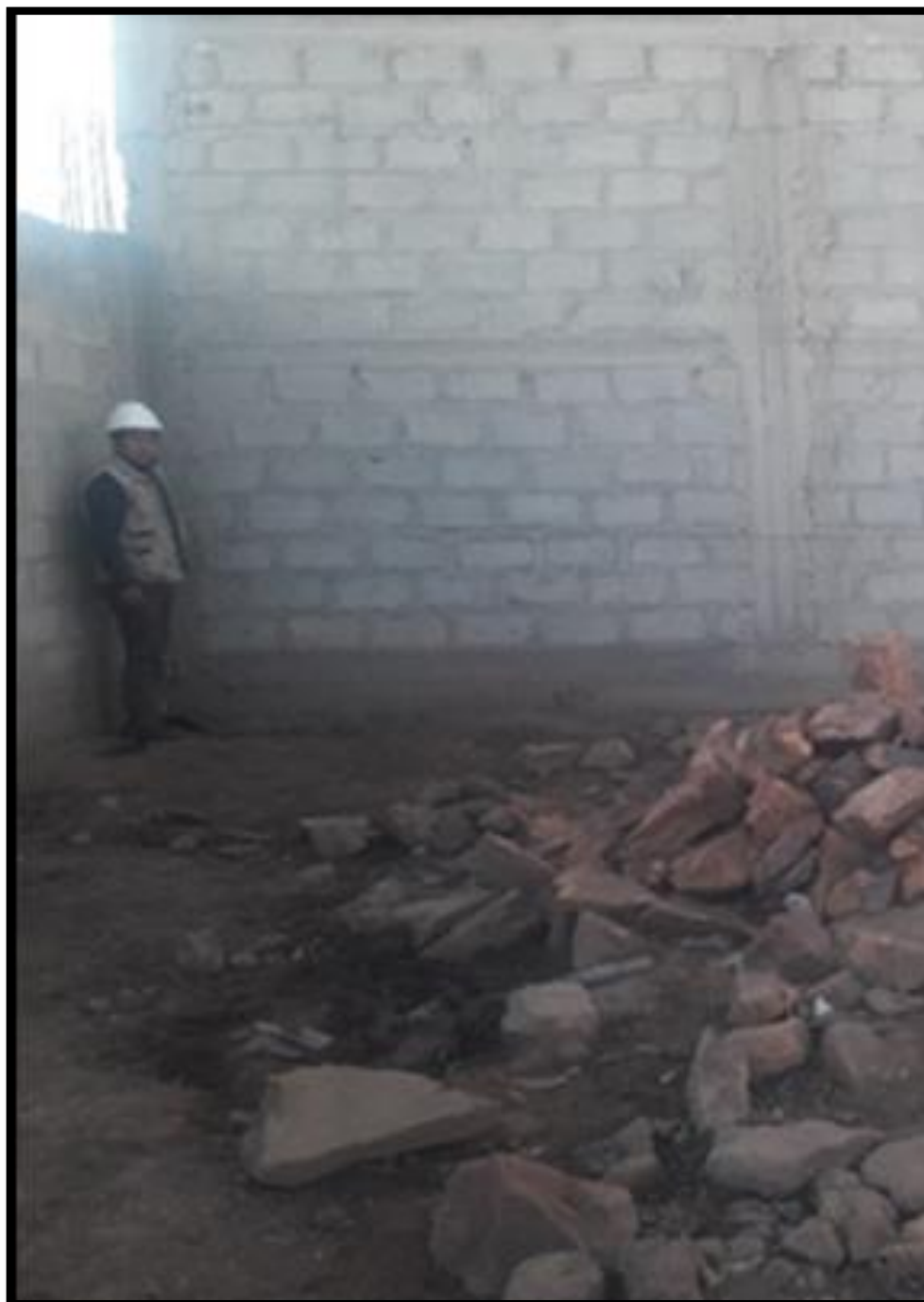
Figura 20 Medición del terreno para el proyecto.
