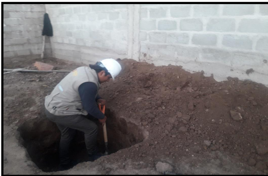
Figura 27 Excavación de calicata.
