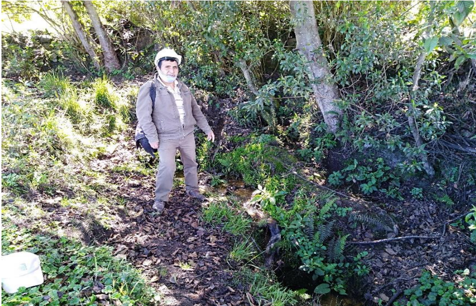
Foto 1. La tubería existente se encuentra descubierta
