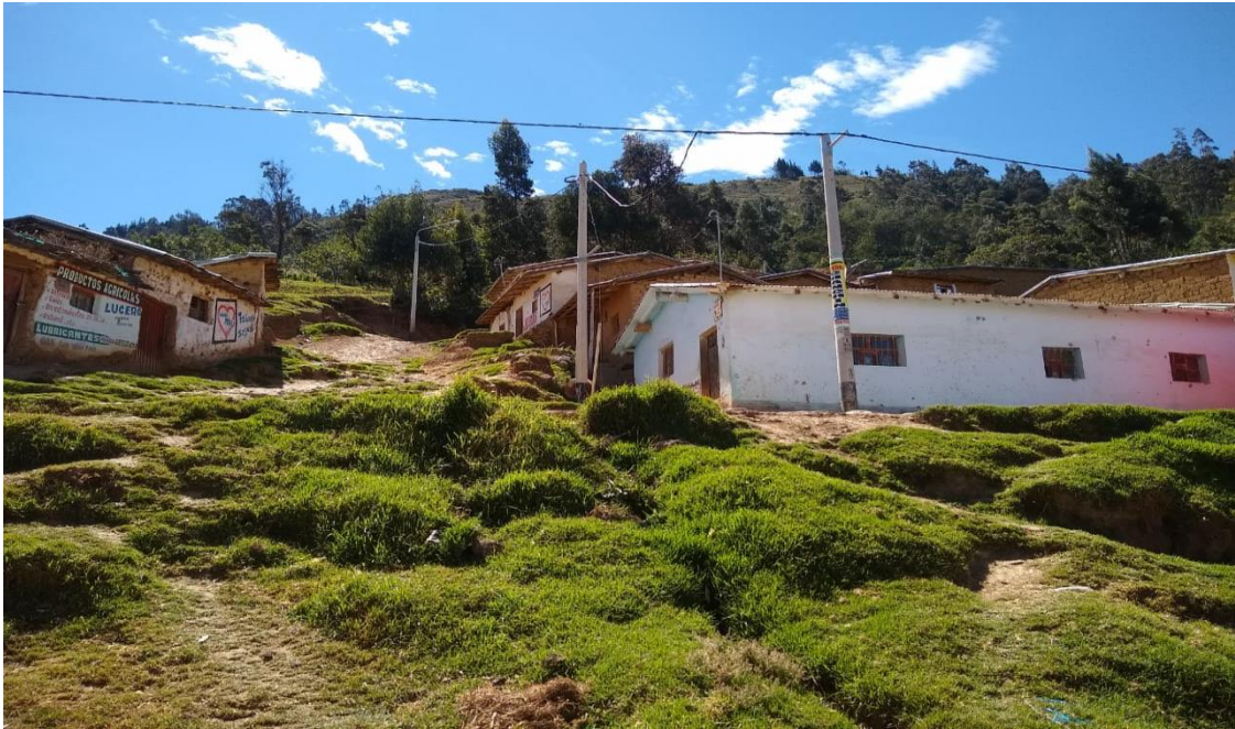
Foto 3. Pendiente para las tuberías de agua como alcantarillado
