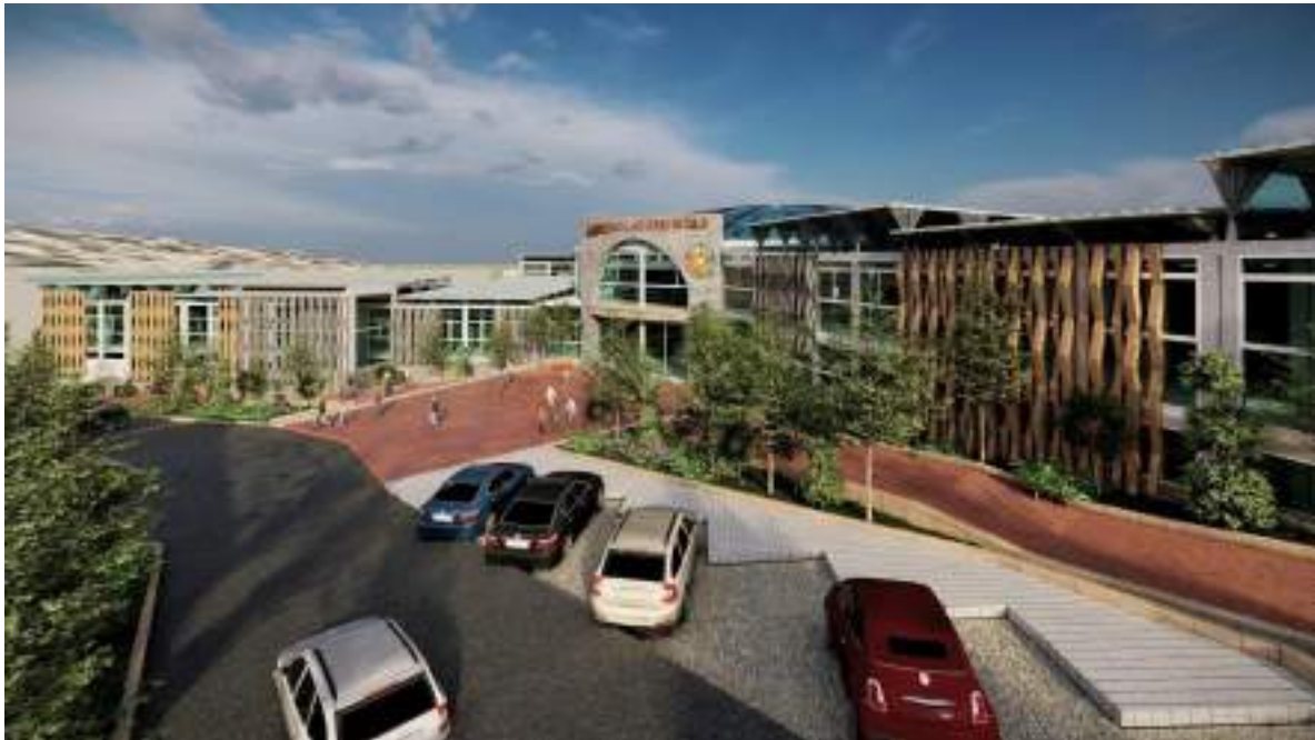
Foto: Av. Francisco Bolognesi – Fachada Principal
