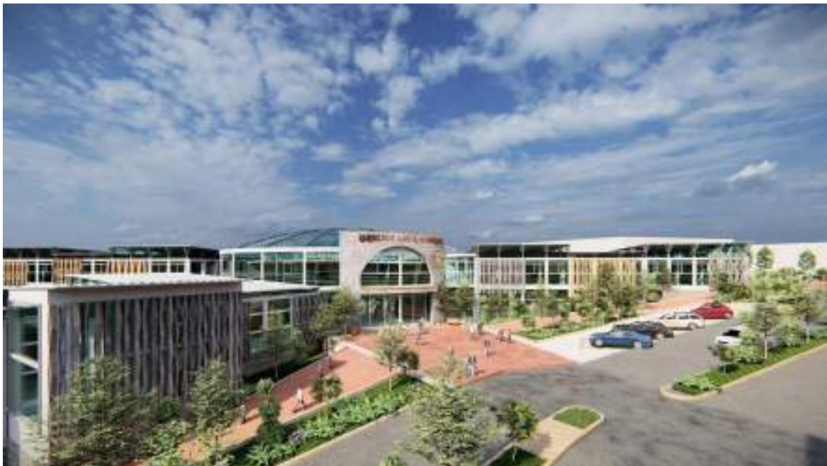
Foto: Av. Francisco Bolognesi – Fachada Principal
