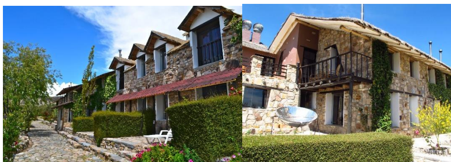
Figura 10 Edificaciones De Manejo De Vegetación
