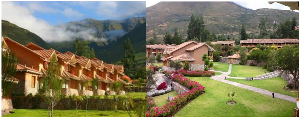
Figura 5 Topografía Del Terreno asemejada a los techos de gradería
