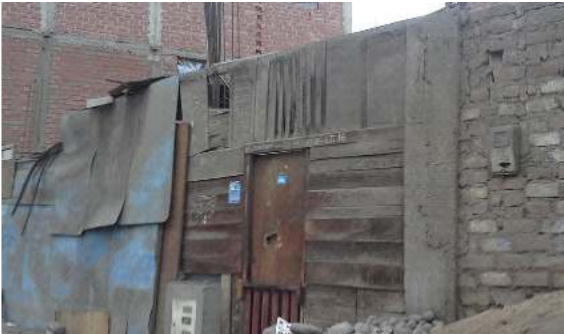
Figura 10. Las viviendas están construidas de materiales mixtos como son: madera, cartón y adobe.
