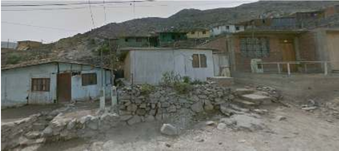
Figura 7. Construyen sus viviendas sin ninguna asesoría técnica, ni miden los riesgos a los que están expuestos.
