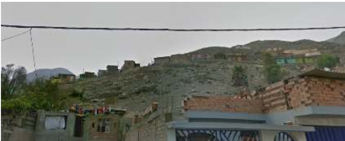
Figura 8. En estos asentamientos no se tiene una planificación urbana, es por ello que carecen de zonas recreativas, centros de salud, zonas de educación.
