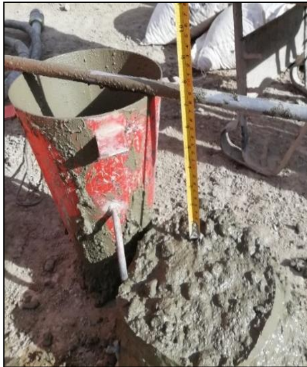
Figura 16. Medición del Slump en concreto patrón f'c=210 kg/cm 2 ..
