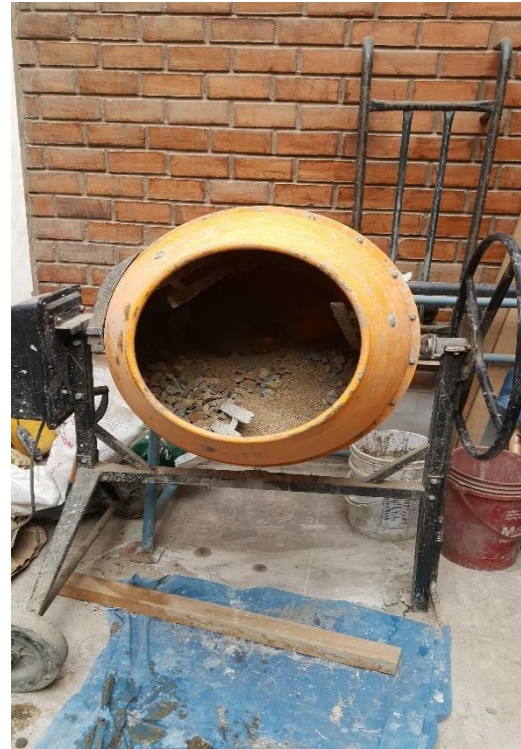
Colocación de los agregados en la mezcladora
