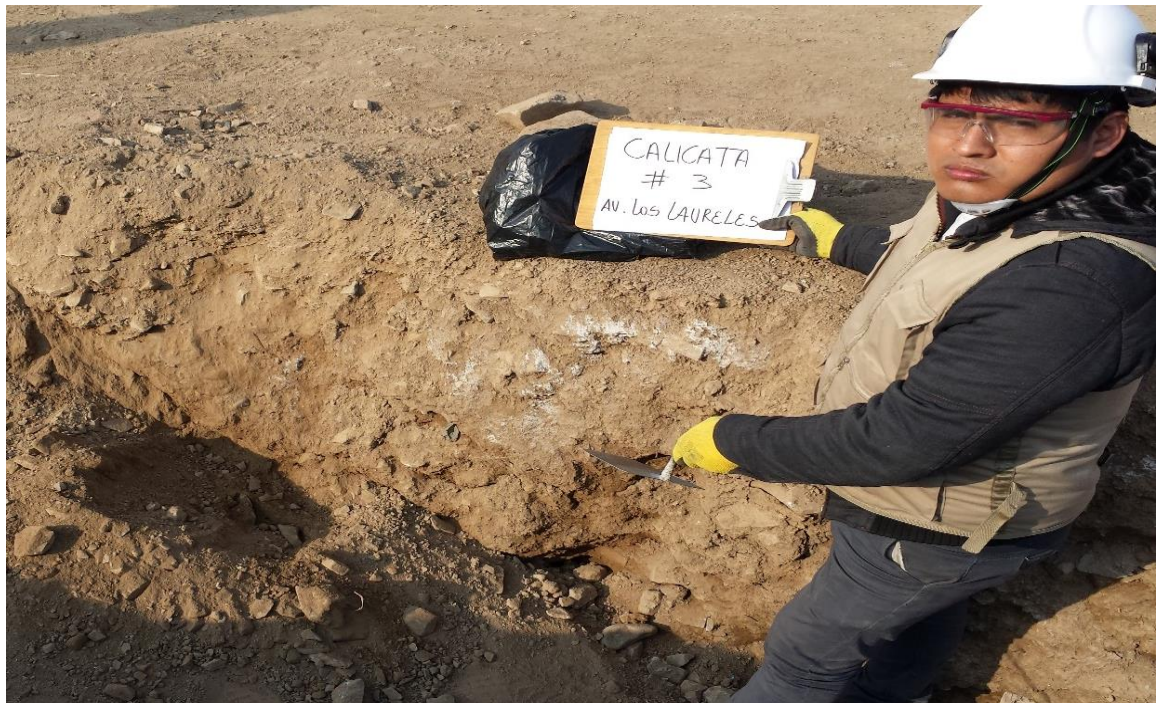
Calicata #3 Avenida Los Laureles
