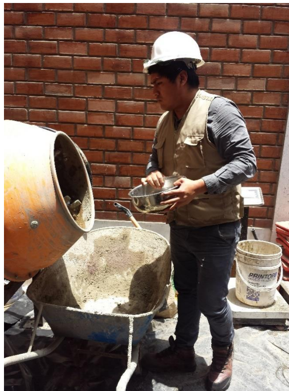
Incorporación de fibra SikaFiber PE
