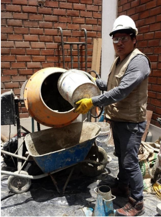
Colocación de los agregados en la mezcladora
