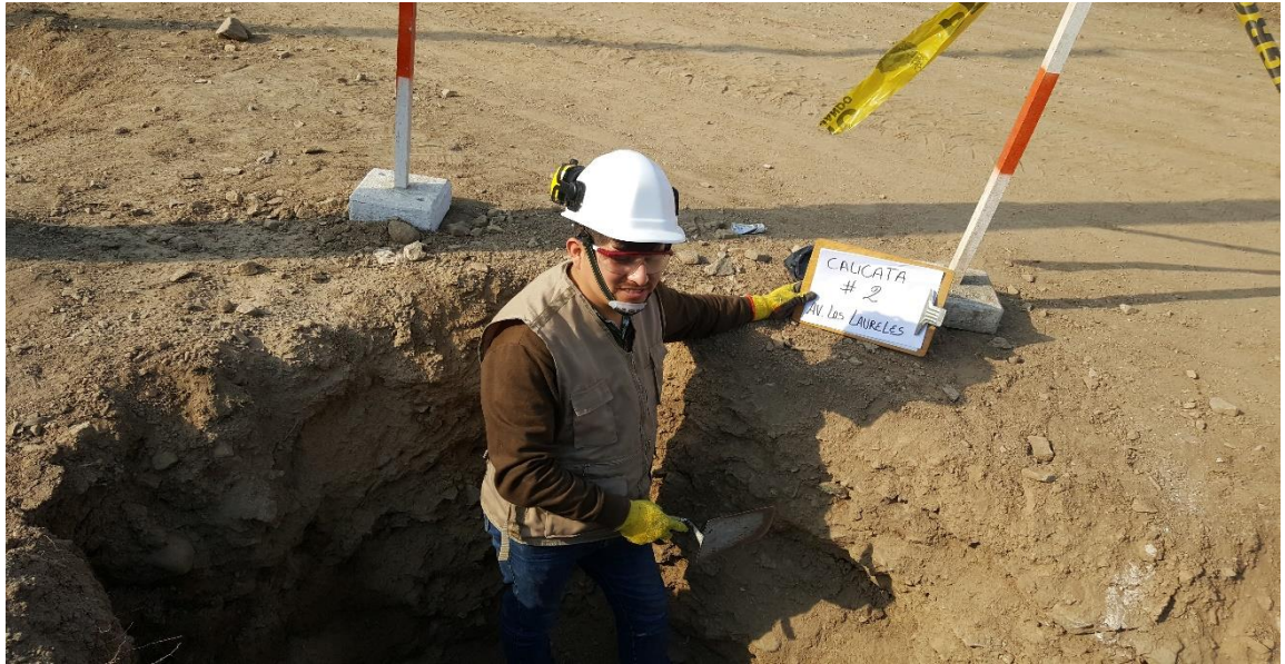
Calicata #2 Avenida Los Laureles
