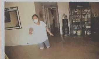
AGUAS SERVIDAS INGRESARON Y LO DESTRUYERON TODO.
