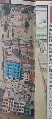
VISTA AEREA DE LA INUNDACION
