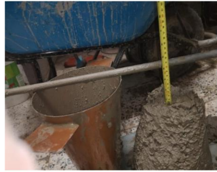
Foto 18: Medición del Asentamiento del concreto con adición de fibras, medido inmediatamente después de culminado el proceso de mezclado
