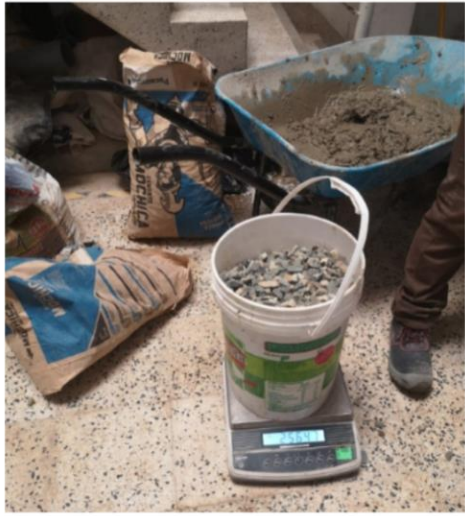
Foto 9: Peso del Agregado Grueso Para Mezcla de Concreto Según Dosificación
