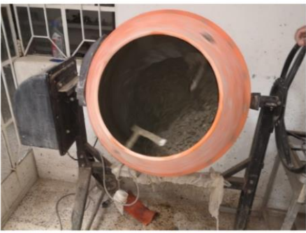
Foto 11: Mezclado de Concreto en Equipo eléctrico (Volumen 0.028 m 3 )
