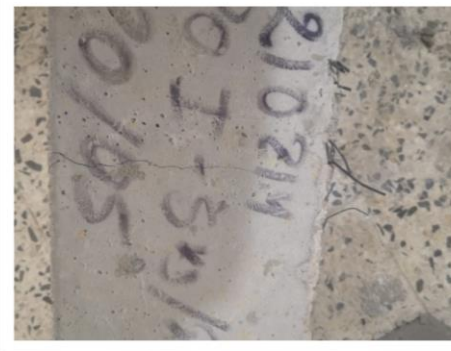
Foto 40: Evidencia de Falla en Viga producto de la aplicación de Cargas (Ensayo a flexión) Concreto con Cemento Tipo I y 5 kg. de Fibra de Polipropileno
