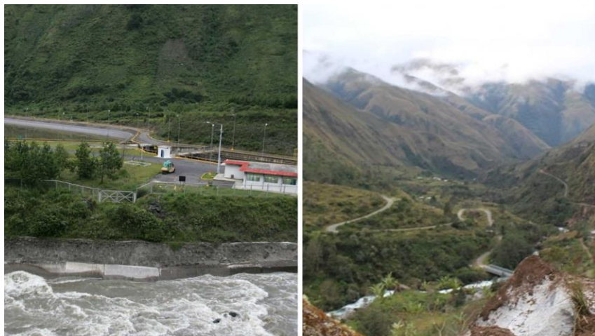
Figura 52: Vista de caudal del rio San Gaban
