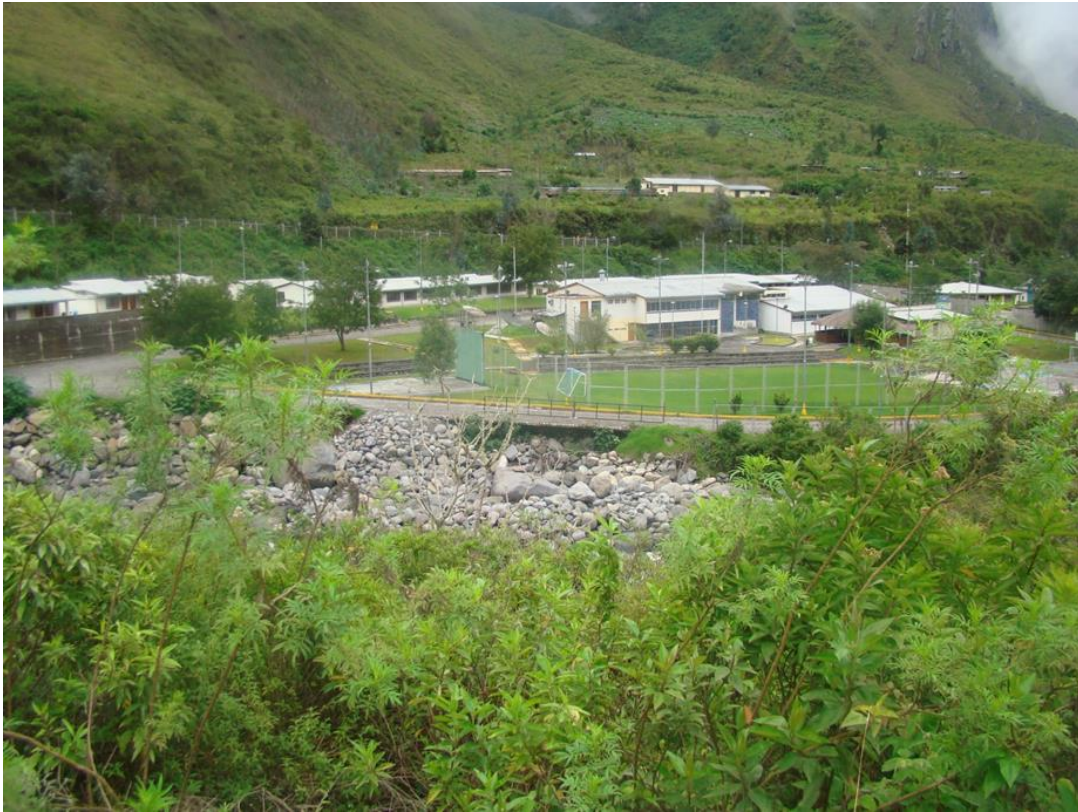
Figura 67: Fotografía vista del lugar de socavación
