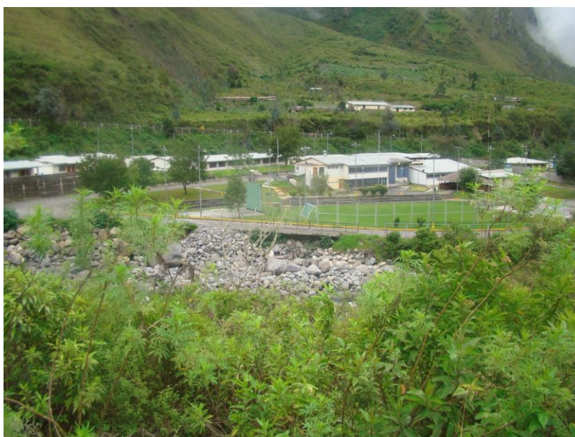
Figura 47: Lugar de socavación
