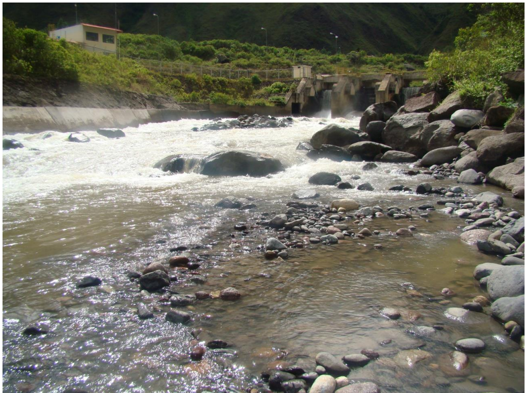
Figura 72: Fotografía vista mostrando el tipo de lecho del rio
