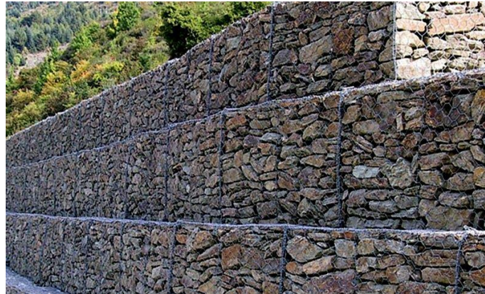
Figura 16:Detalle de muro de gaviones
