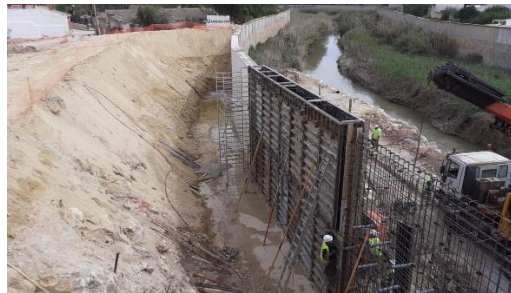
Figura 39: Muro de encauzamiento
