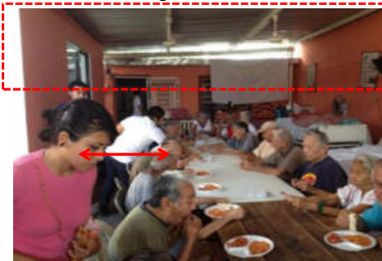
Figura 15. CAUSA 1.2 El techo del comedor cuenta con una cubierta precaria con calaminas y no cuenta con protección de la ventana alta. Se observa que la atención al comedor se da en sobre condiciones de difícil circulación para los adultos mayores
