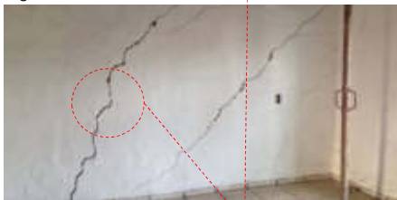
Figura 13. Fallas Estructurales
