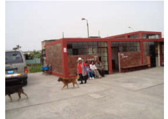
Figura 63. Estado actual Centro Residencial los Martincitos
