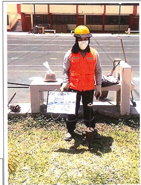
Foto N°04: Vista de la auscultación DPL-02, de 0.00 a 2.50m de profundidad, compacto a muy compacto.
