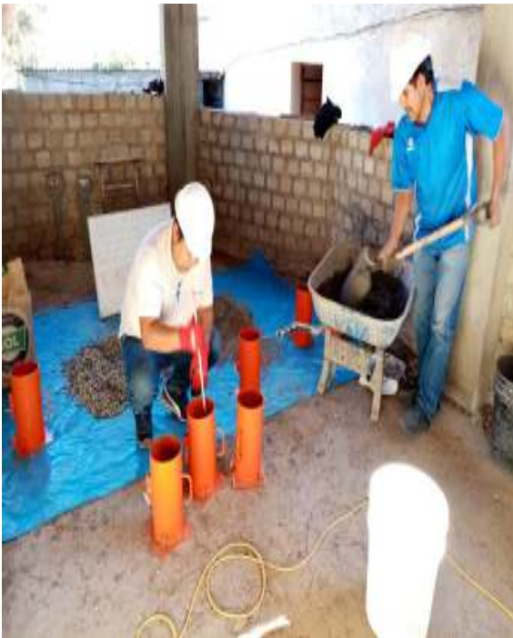
Fig. n°07 y Fig. n° 08: Vista del llenado y compactado de concreto en las briquetas cumpliendo con las normas, compactado con una varilla 25 veces en cada capa
