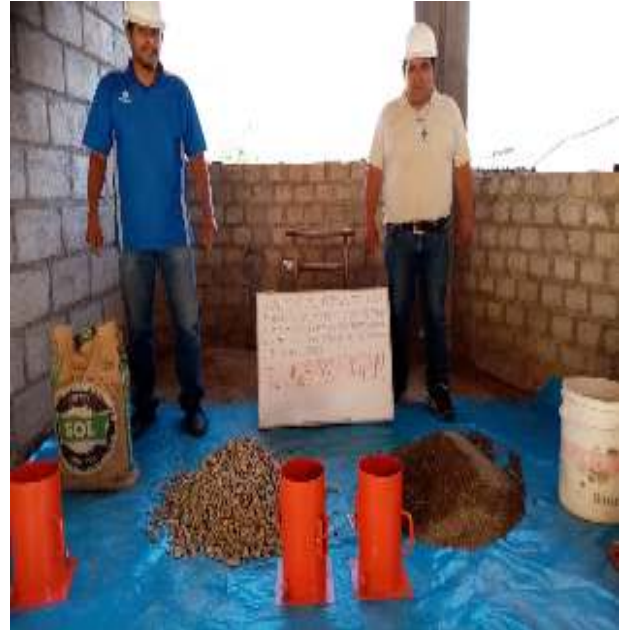
Fig. n°06: Vista de los diferentes Materiales que se utilizan en el concreto
