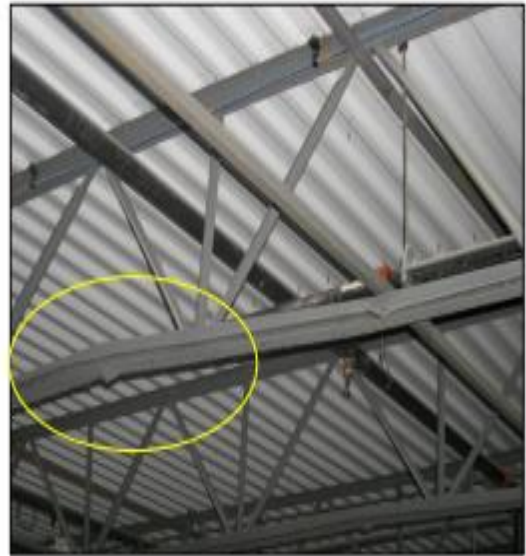
Figura 3. Falla en viga de alma abierta por pandeo local, fuente San Salvador 2012.
