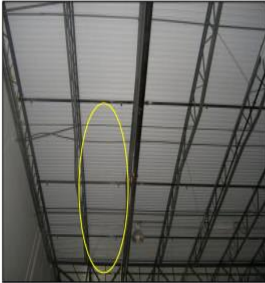
Figura 3. Falla en viga de alma abierta por pandeo local, fuente San Salvador 2012.
