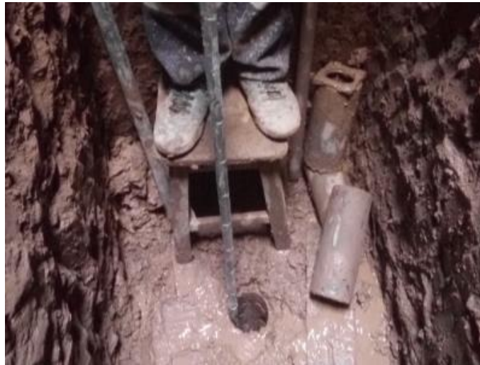
Figura N° 14: Perforación en fondo de calicata
