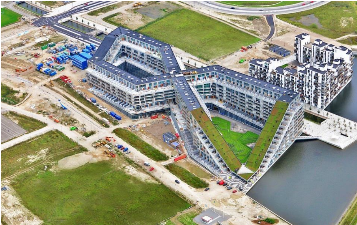
Imagen 2 – Vista Exterior del proyecto
