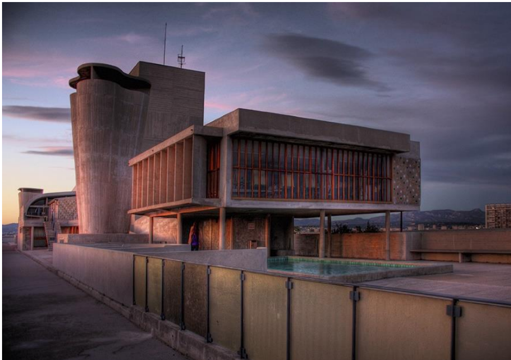
Imagen 11 – Azotea donde se ubica el uso común del edificio
