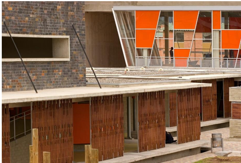
Figura 14. Fachada Lateral colegio Gerardo Molina
