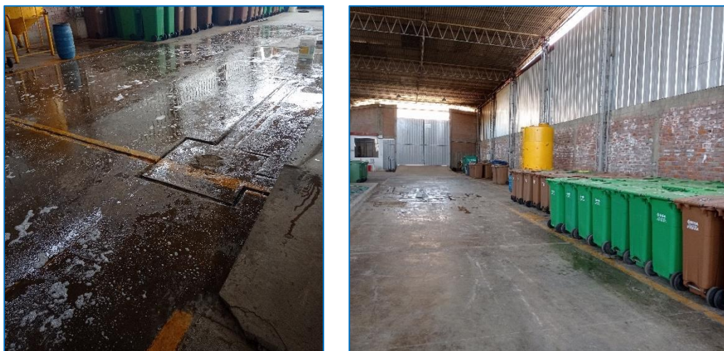
Figura 40. Ejecución de limpieza de piso
