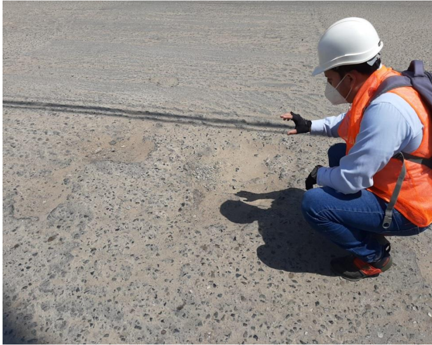
Ilustración 05: presencia piel de cocodrilo
