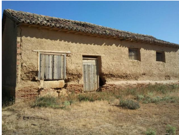
Figura 15 Vivienda de adobe
