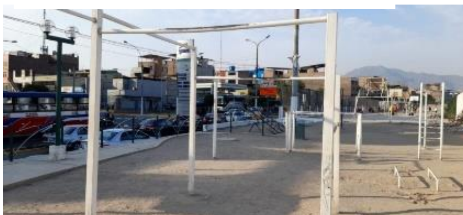
Pavimento de espacio deportivo
