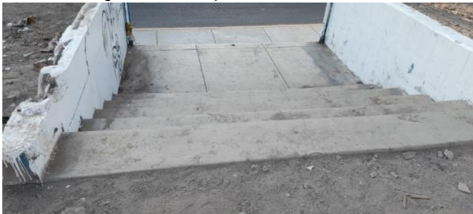
Escalera de ingreso a loza deportiva
