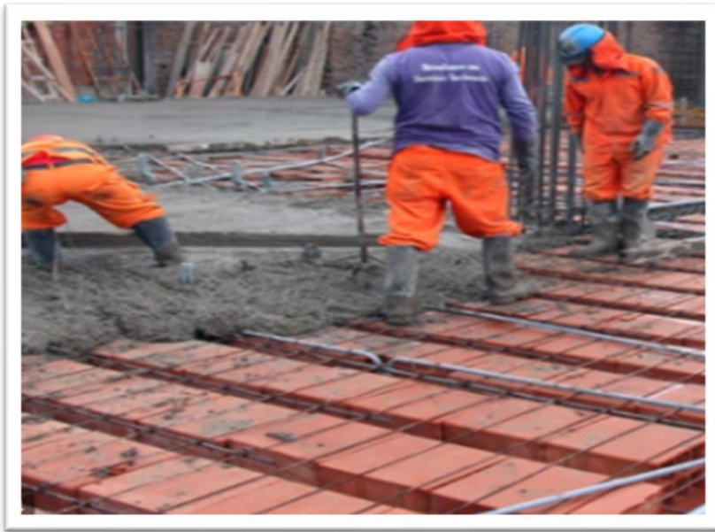
Figura n°28 vaciado del concreto de la losa convencional
