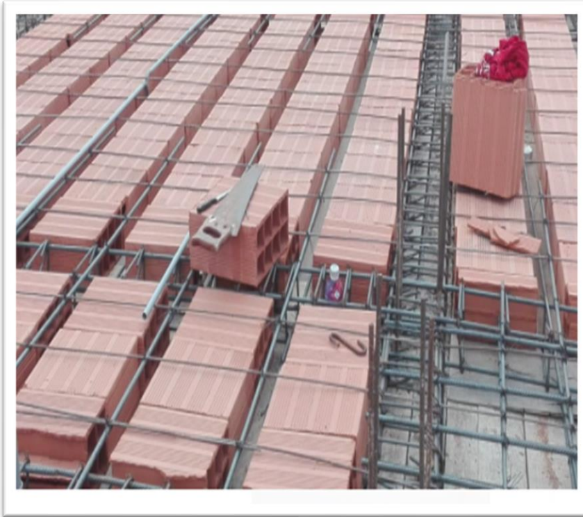
Figura n°26 colocación de ladrillos y acero losa convencional
