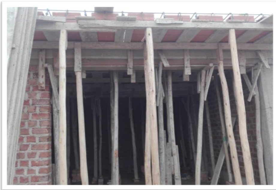
Figura n°25 proceso de encofrado de la losa convencional
