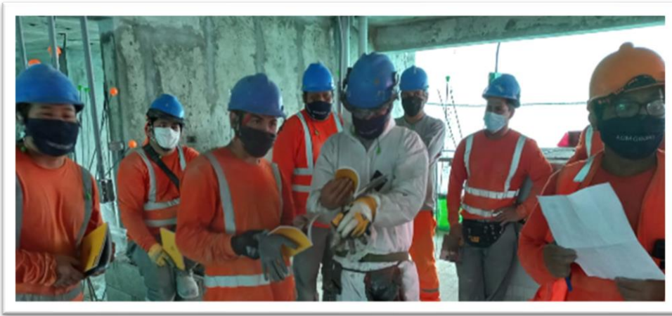
Figura n°24 fotos a los maestros con la guía de construcción
