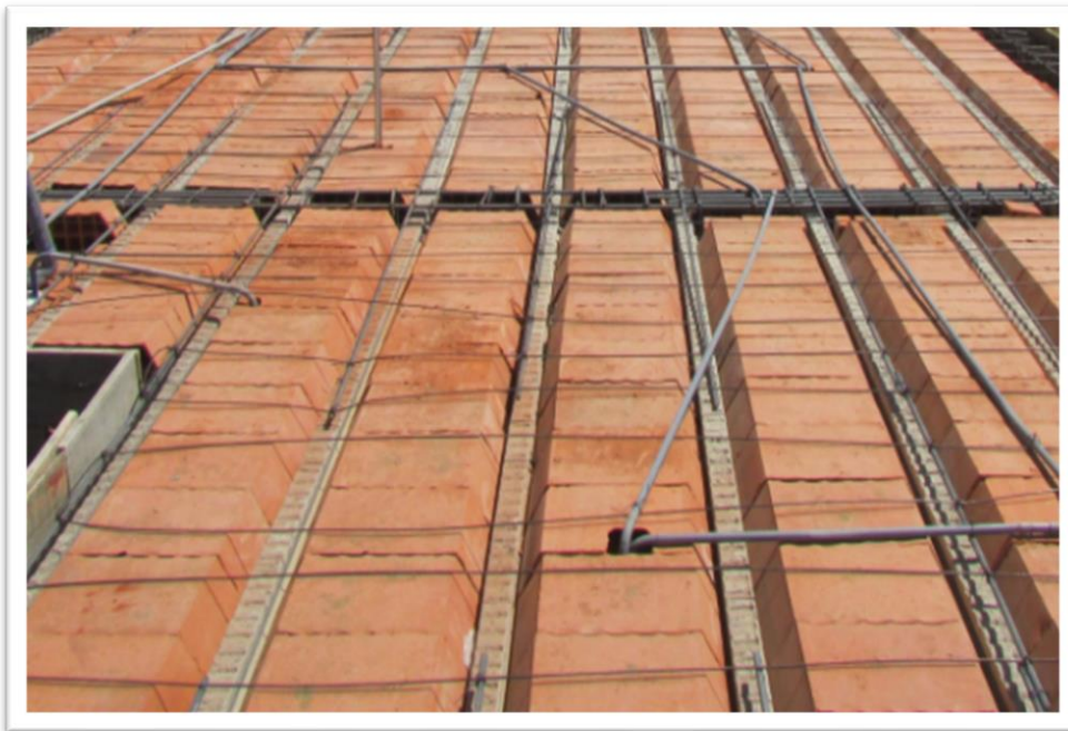
Figura n°33 colocación de la instalación eléctrica y sanitaria
