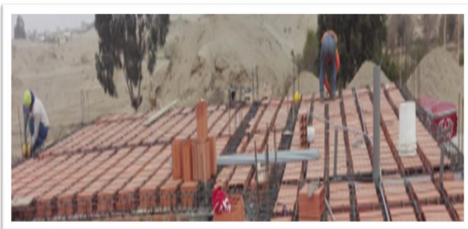
Figura n°27 colocación de instalaciones sanitarias y eléctricas
