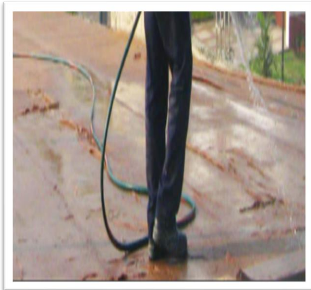
Figura n°29 curado de la losa convencional
