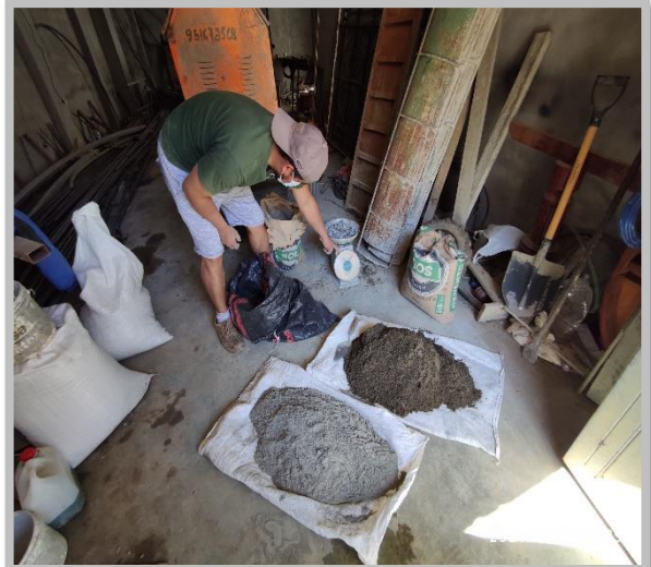
Imagen 19 y 20. Pesado de materiales para la preparación de concreto
