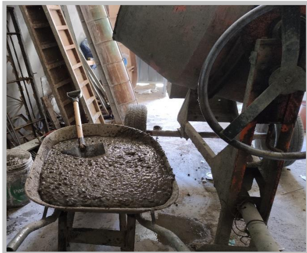
Imagen 21 y 22. Preparación de concreto
