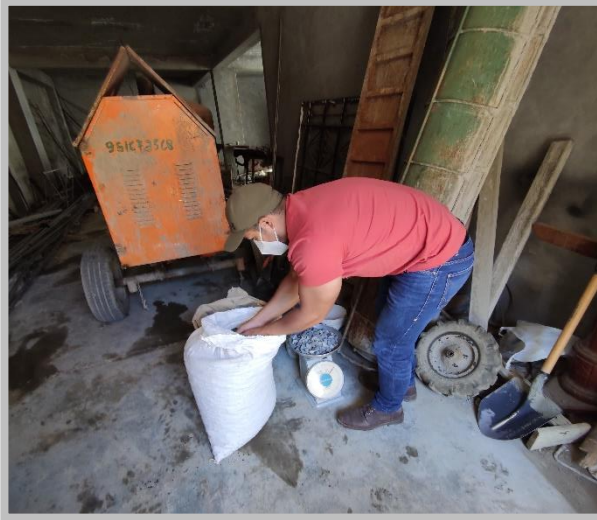
Imagen 19 y 20. Pesado de materiales para la preparación de concreto
