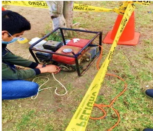
Figura 07: Instalación del motor generador
